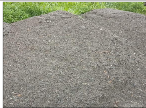
Entrega de agregado arena de rio
