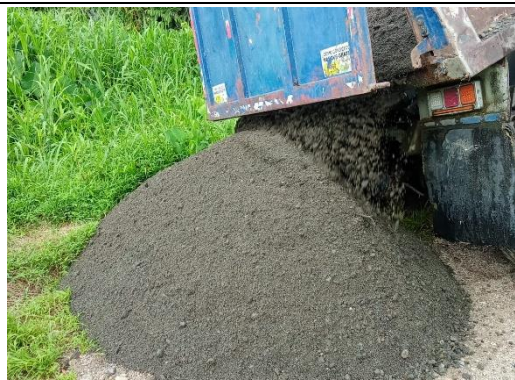
Entrega de agregado arena de rio
