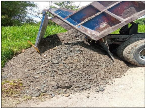
Entrega de material de rio - Afirmado
