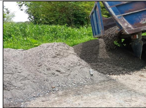
Entrega de agregado arena de rio
