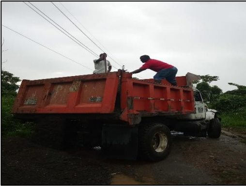
Entrega de agregado arena de rio
