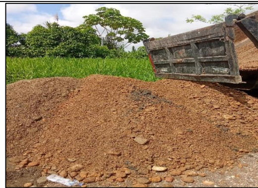
Entrega de material de rio - Afirmado
