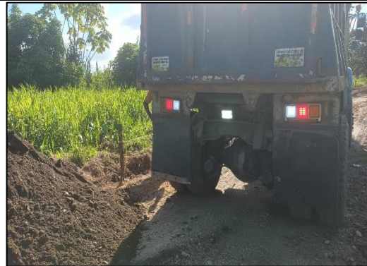
Entrega de material de rio - Afirmado
