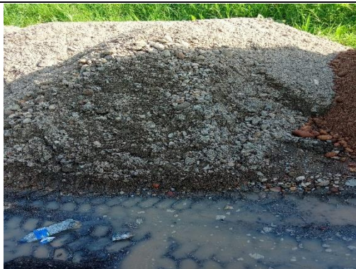
Entrega de material de rio - Afirmado
