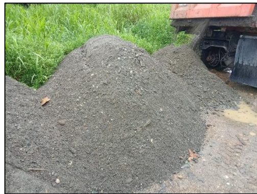
Entrega de agregado arena de rio
