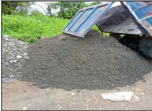
Entrega de agregado arena de rio
