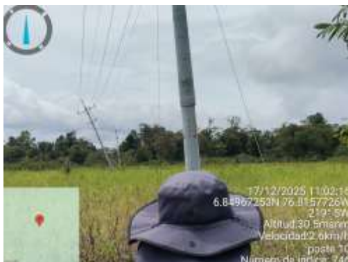
Ilustración 4. Verificación de recorrido de despeje de zona
