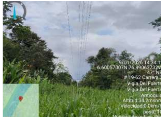
Ilustración 2. Inspección de trabajos de mantenimiento
