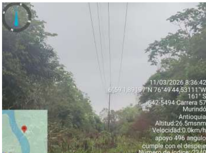
Ilustración 6. Verificación de recorrido de despeje de zona
