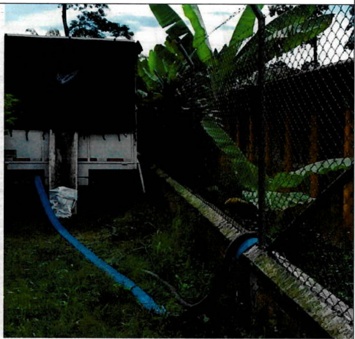
Ingreso de vector al pozo
