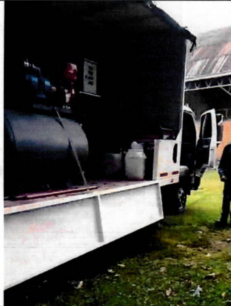
Ingreso de vector al pozo
