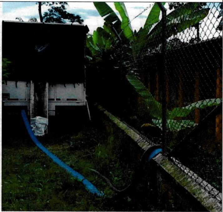
Ingreso de vector al pozo
