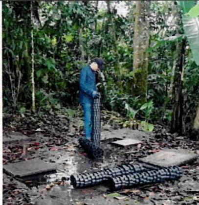
Instalación de rosetones
