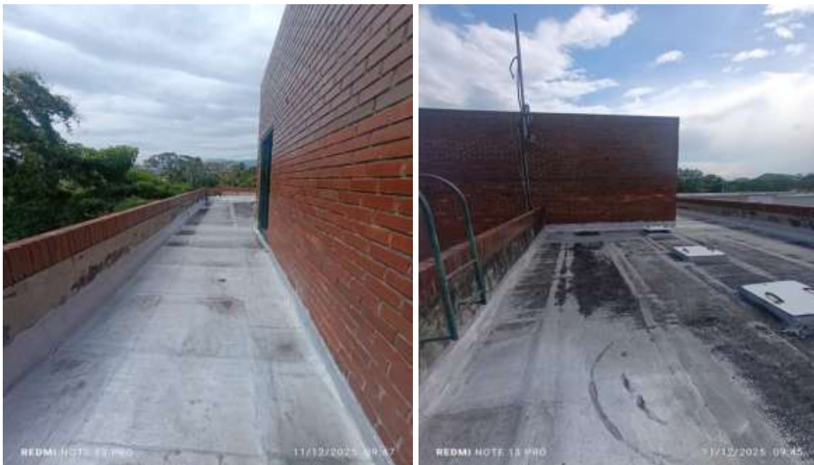
Condiciones del manto, escotillas y muros en la terraza
