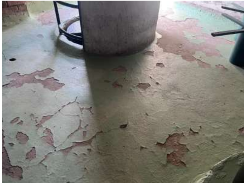
Condiciones actuales del piso – nivel No. 4.
