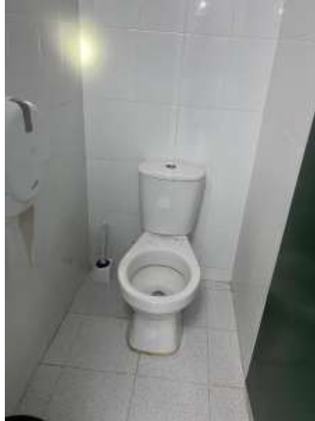
Baño - Sanitario sin tapa – condición actual.
