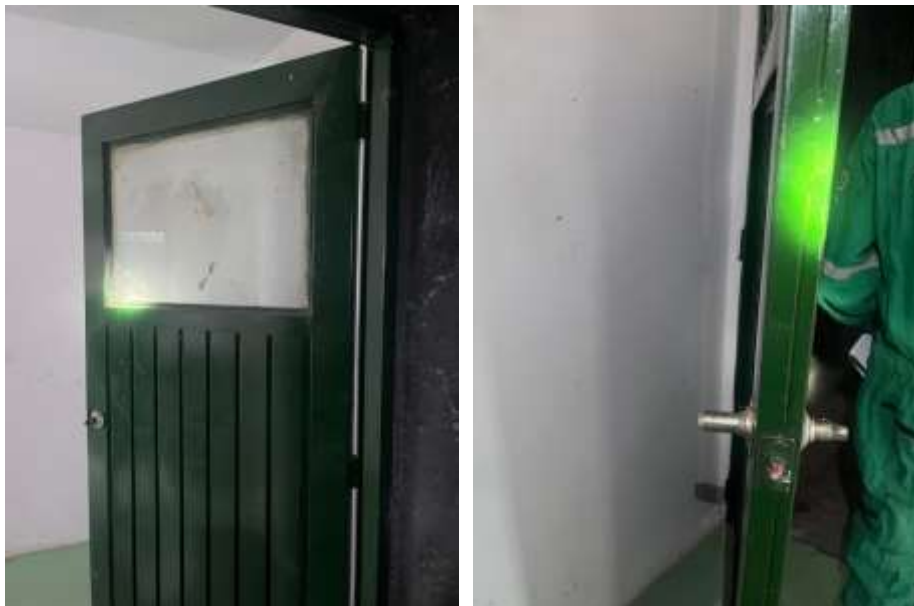
Puerta de acceso lateral – piso No. 1.
