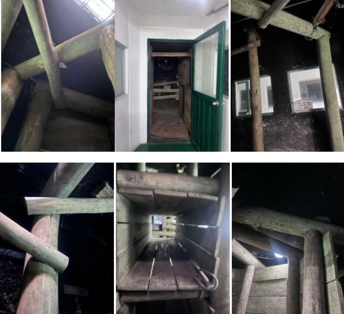
Condiciones actuales de la madera en los obstáculos de entrenamiento.
