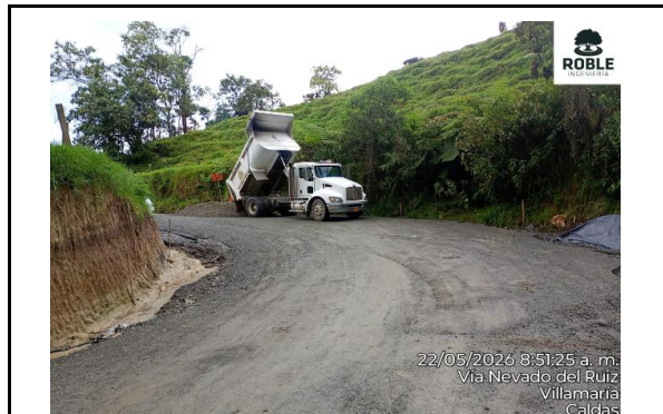
APLICACIÓN DE BASE - TRAMO 02 TERMALES
