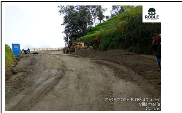
APLICACIÓN DE SUB BASE- TRAMO 3 EL PONTÓN
