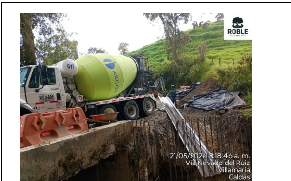
VACIADO ALETA ENCOLE DEL PONTÓN- TRAMO 3
