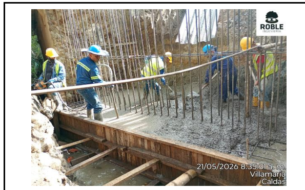
VACIADO ALETA ENCOLE DEL PONTÓN- TRAMO 3
