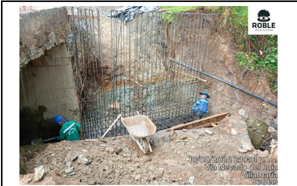
INSTALACIÓN DE ACERO PONTÓN- TRAMO 3
