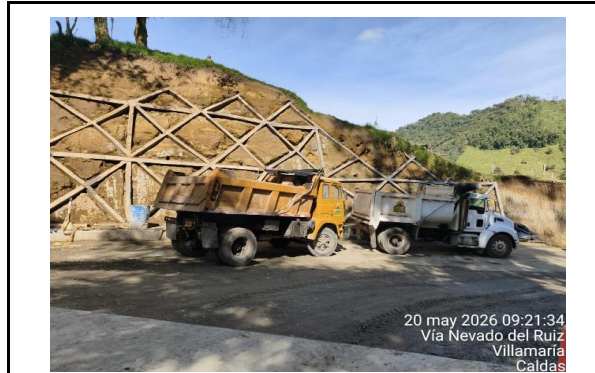
PERFILACIÓN DE TALÚD - TRAMO 3 PANTALLA
