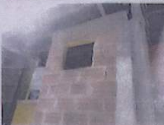
Descripción: PARED FACHADA
