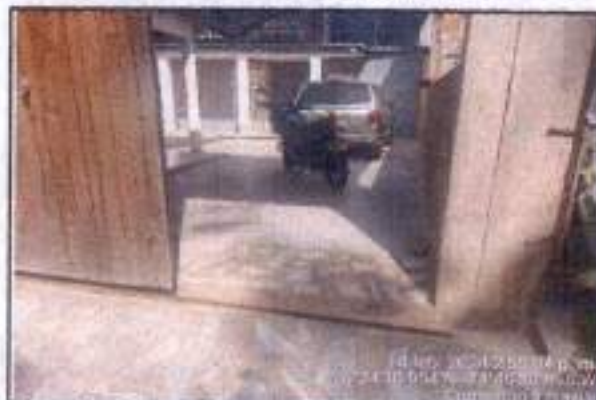
Observaciones: Ingreso vivienda
