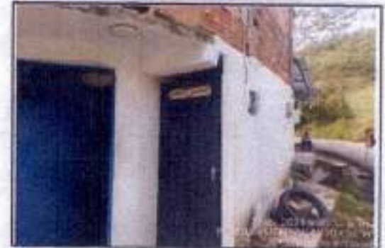
Observaciones: Fachada lateral
