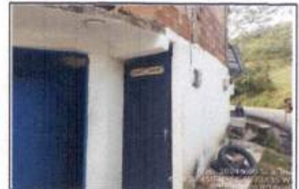
Observaciones: Fachada lateral
