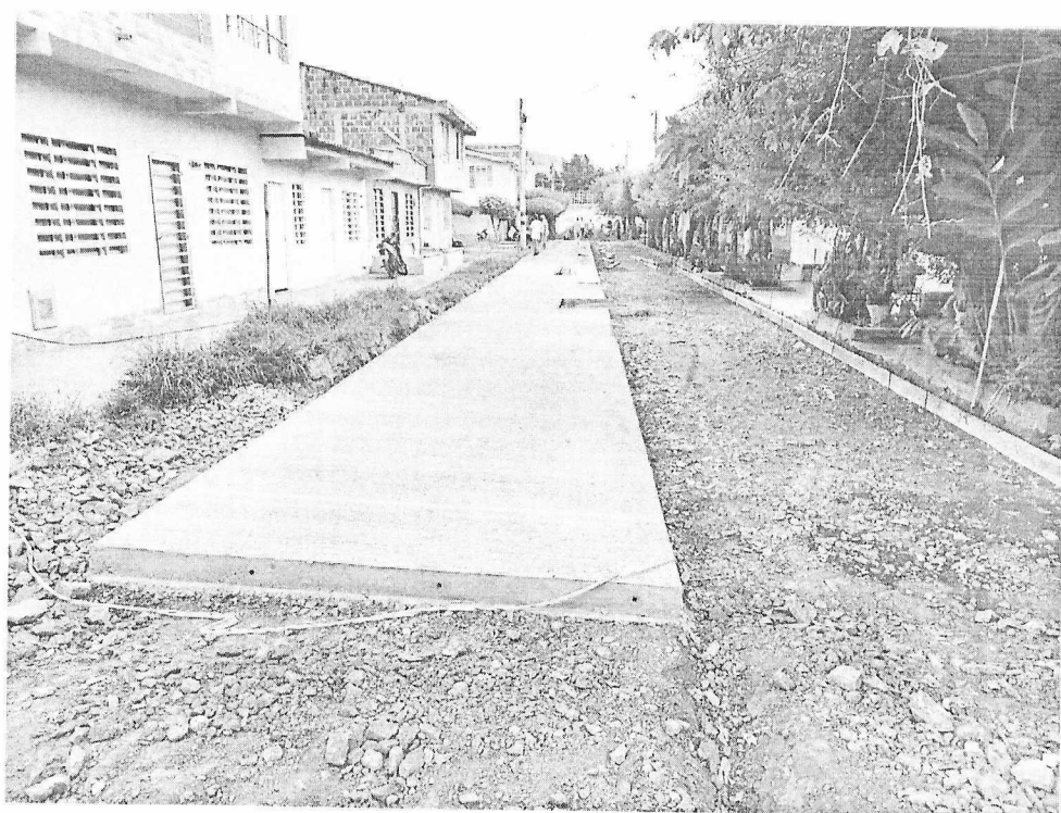
Ilustración 5. . Suministro de cemento y pétreos para la calle 13A entre carreras 10 y 10 A
