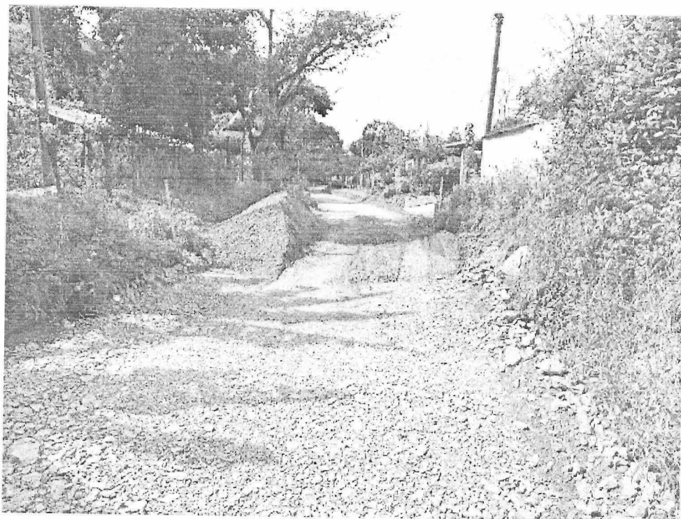
Ilustración 9. Suministro de rocamuerta y subbase El Hobo
