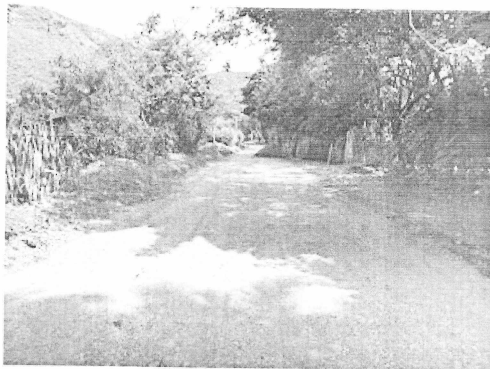
Ilustración 8. Suministro de rocamuerta y subbase El Hobo
