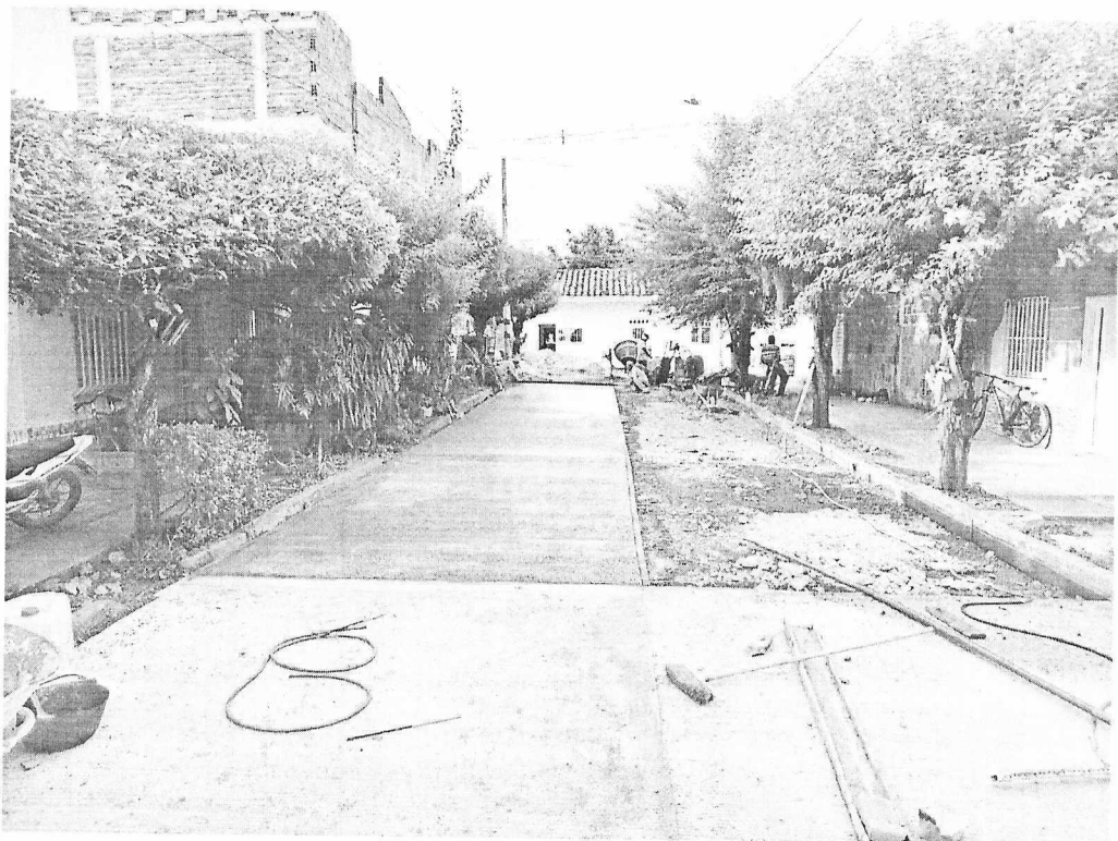
Ilustración 4. . Suministro cemento y pétreos para la calle 13A entre carreras 10 y 10 A
