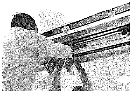
Imagen 18. Calibración tope puerta principal
