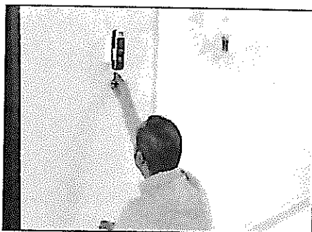
Imagen 39. Evidencia Mantenimiento lector comedor
