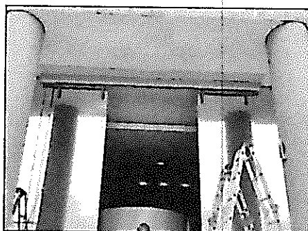
Imagen 4. Evidencia montaje tapa protectora mecanismos
