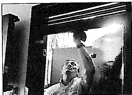
Imagen 20. Evidencia Mantenimiento Imanes Cuarto de Servidores
