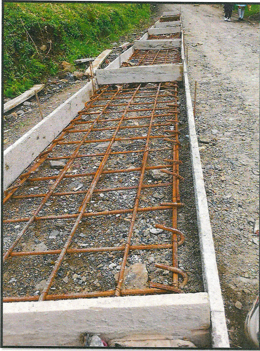
Ilustración 1. Instalación formaleta y aceros de refuerzo huellas para construcción huellas en concreto
