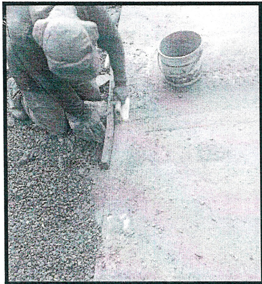
Ilustración 3. Reparación rampas de acceso
