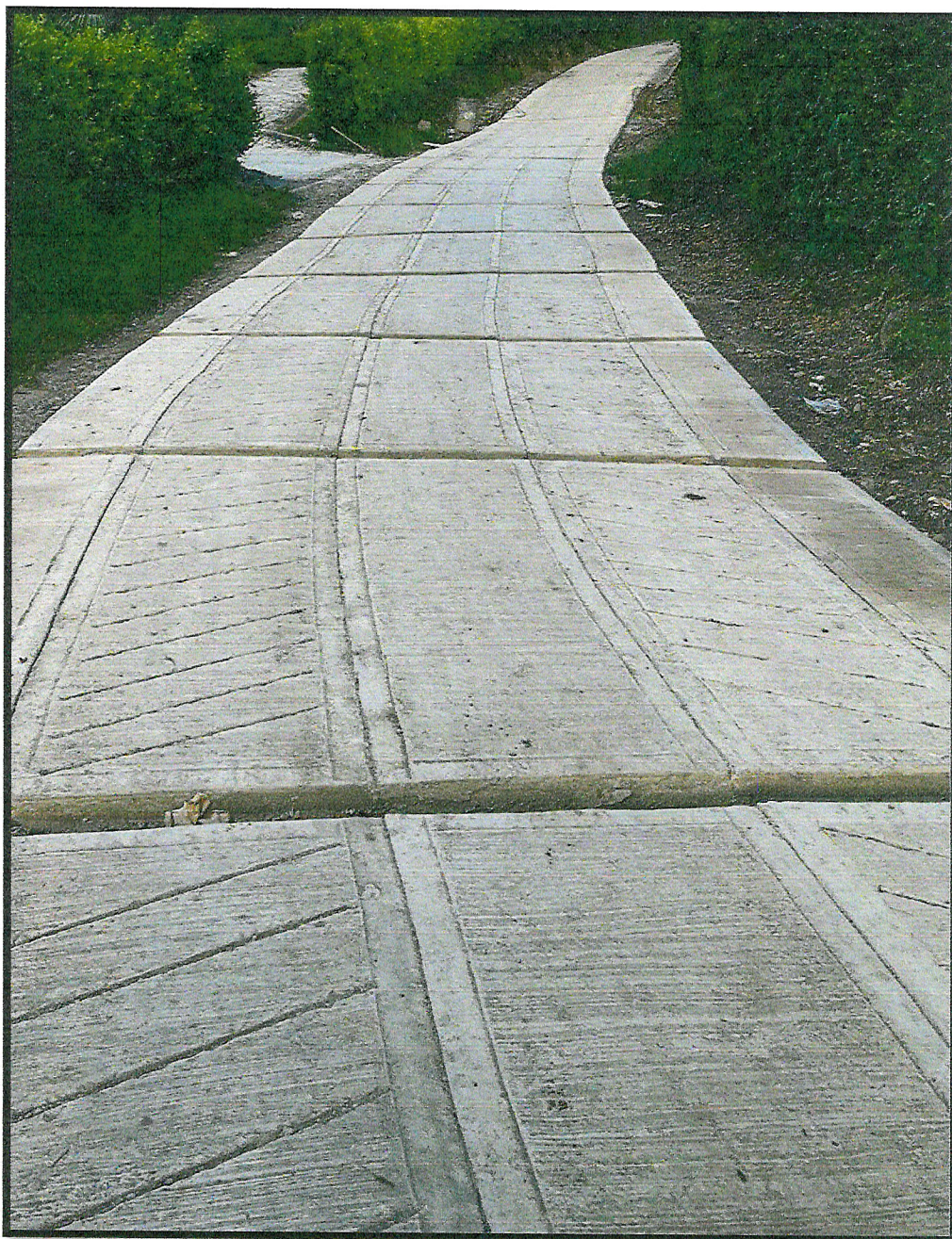
Ilustración 4. Concreto 3000 psi. Construcción huellas y vigas
