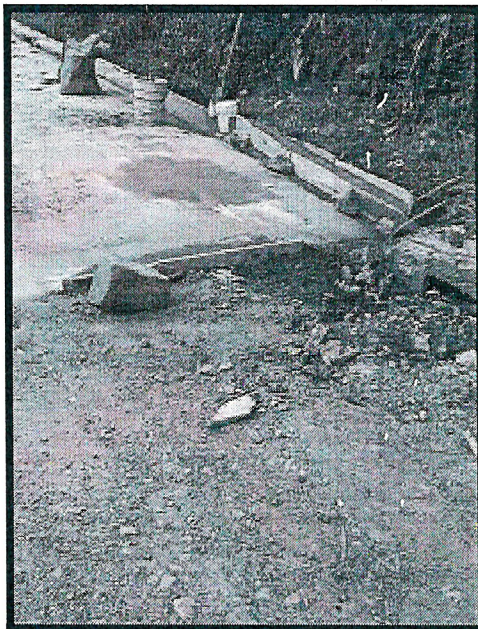
Ilustración 6. Reparación rampas de acceso
