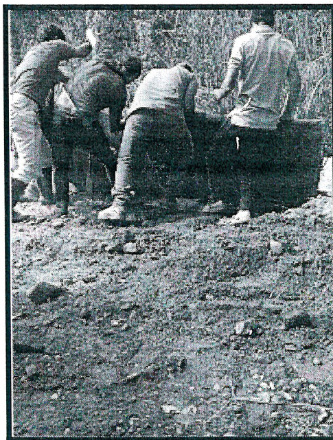
Ilustración 2. Comunidad extendiendo escombros para cerramiento de vía
