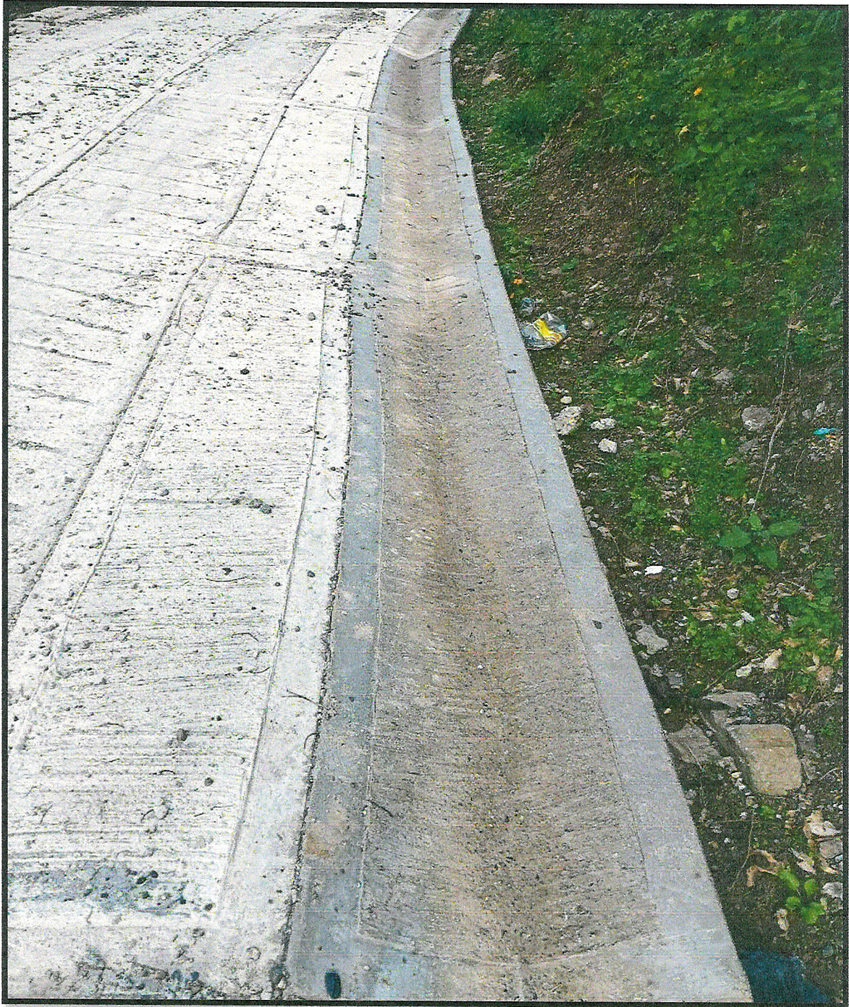
Ilustración 5. Construcción cunetas Y Bordillos
