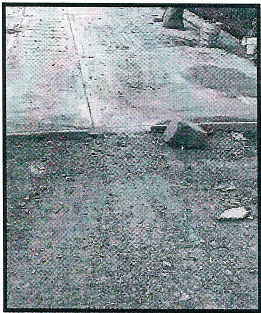
Ilustración 5. Reparación rampas de acceso
