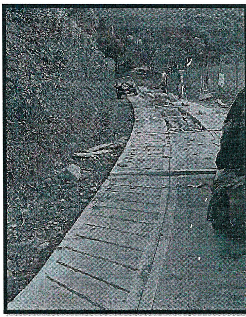
Ilustración 8. Paso de vehículos de la comunidad durante instalación de formaleta y fundida
