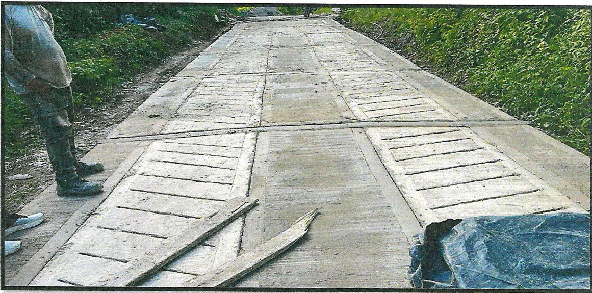
Ilustración 2. Construcción concreto ciclópeo
