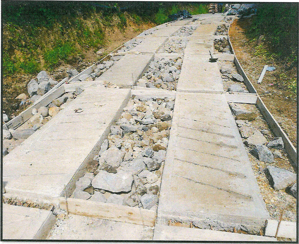
Ilustración 2. Construcción concreto ciclópeo
