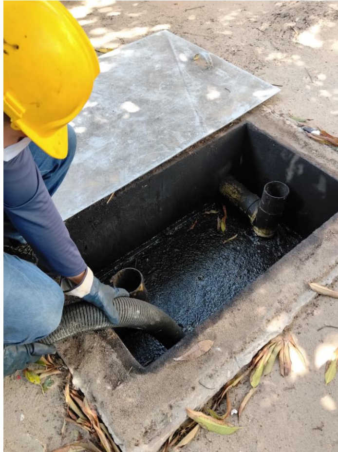
Limpieza de trampa #1
