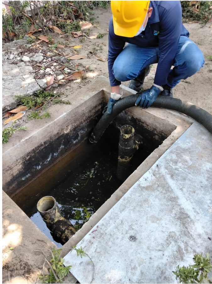
Limpieza de trampa #2
