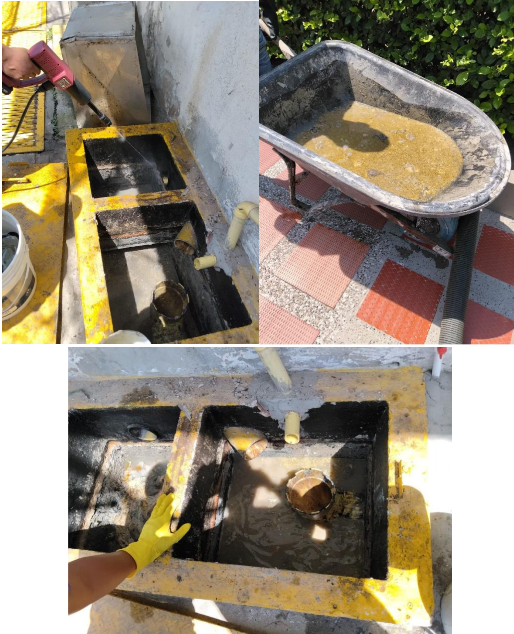
Limpieza de Trampa #3
