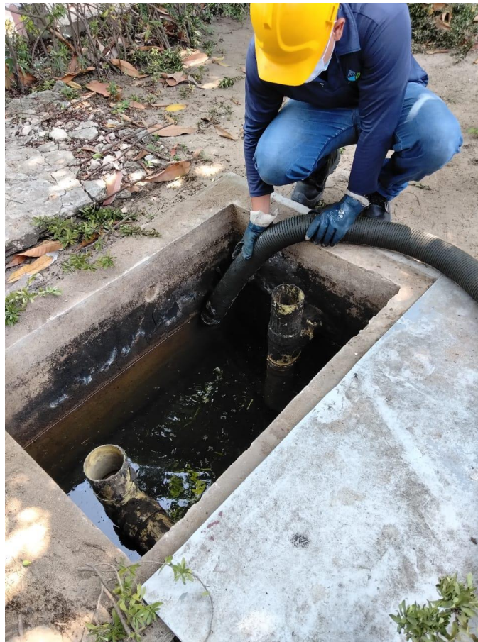
Limpieza de trampa #2
