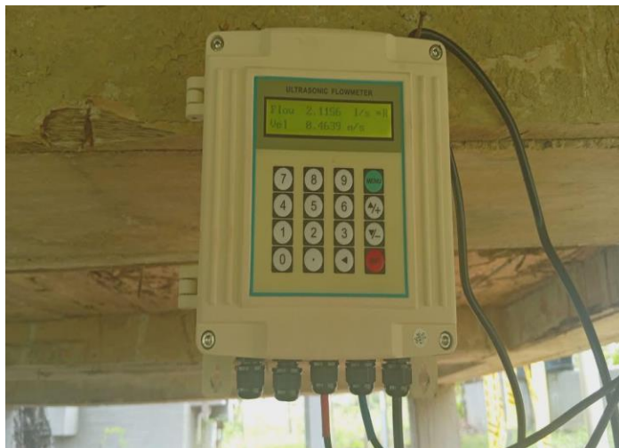
Foto 1. Unidad transmisora del medidor ultrasónico instalada bajo la losa de la PTAP. Pantalla LCD muestra Flow: 2,1156 l/s; Vel: 0,4639 m/s. (CABP, marzo 2026)
