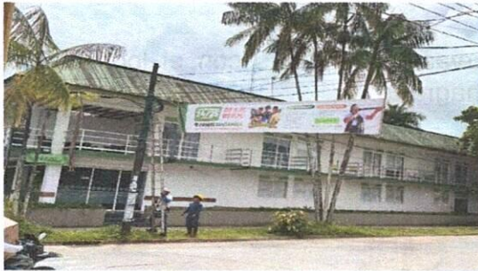
Fotografía 10: Instalación de pasa calle en la calle 7 con crra 10
