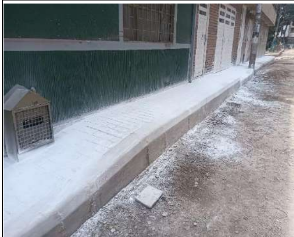
Instalación y estampado de concreto en andenes
