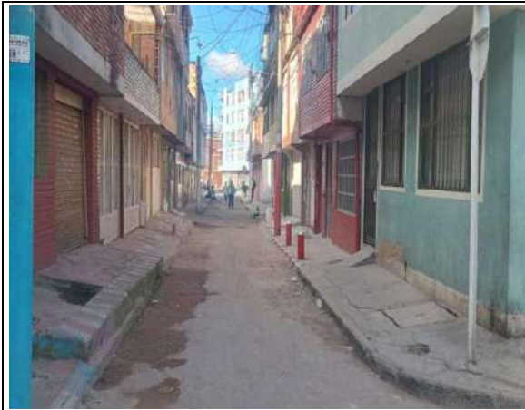
Estado actual del frente de obra
