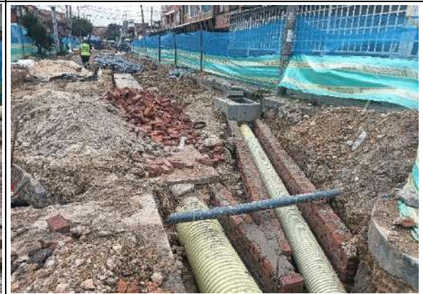
Construcción de cárcamo
