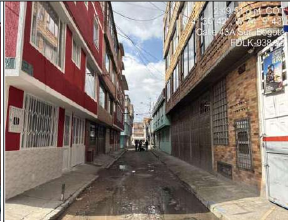
Estado actual del frente de obra
