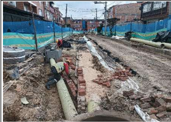
Construcción de cárcamo
