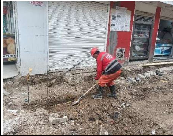
Excavación manual en andenes
