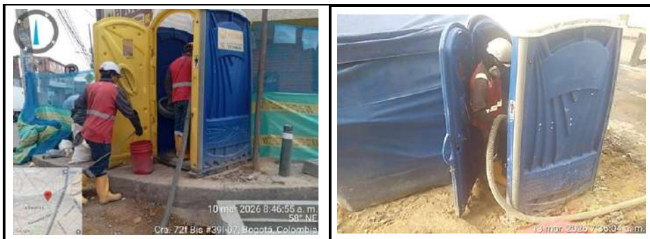
Imagen 5 Mantenimiento de Baños
