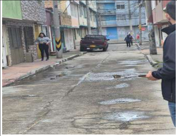
Estado actual del frente de obra
