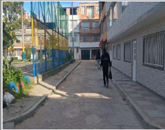
Estado actual del frente de obra
