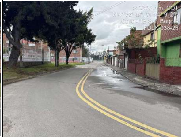
Estado actual del frente de obra
