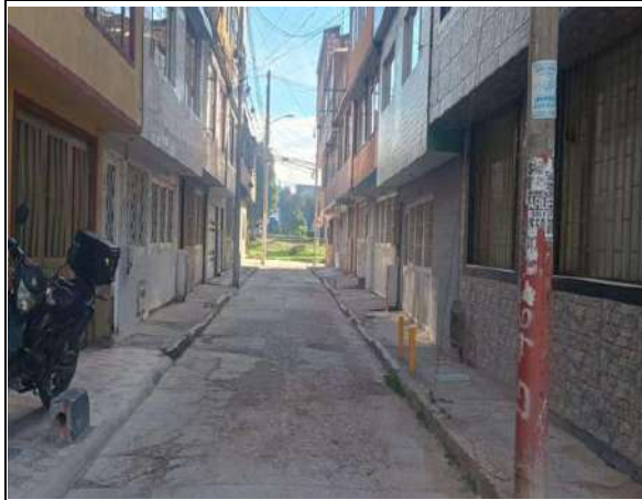
Estado actual del frente de obra
