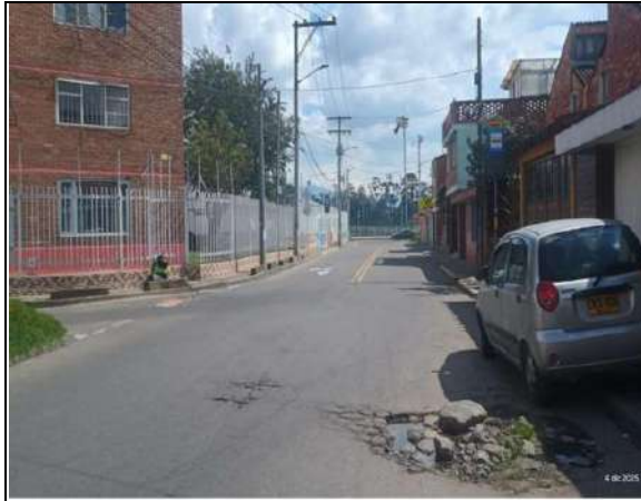
Estado actual del frente de obra
