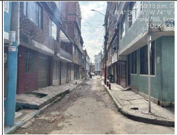
Estado actual del frente de obra
