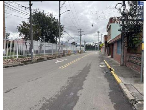
Estado actual del frente de obra
