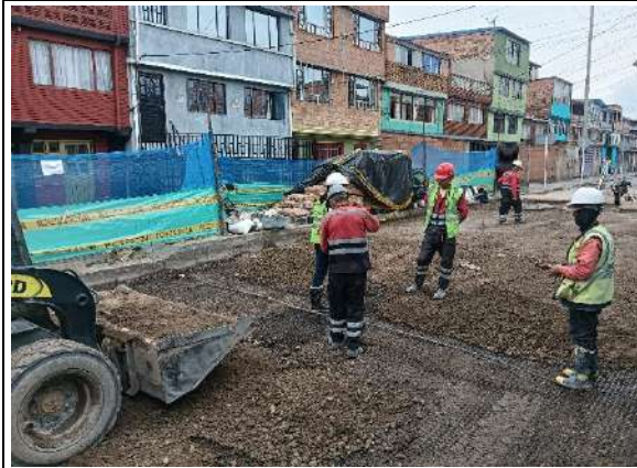
Instalación de geomalla y base granular estabilizada
