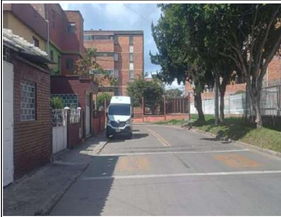
Estado actual del frente de obra
