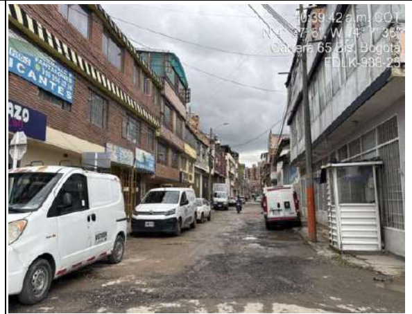
Estado actual del frente de obra
