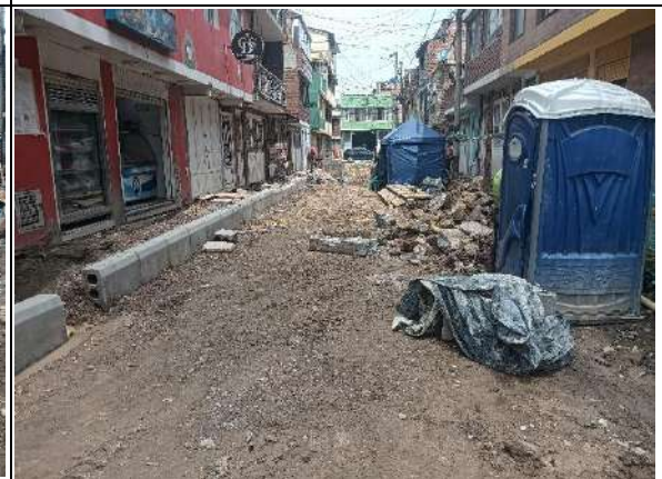
Demolición de concreto existente
