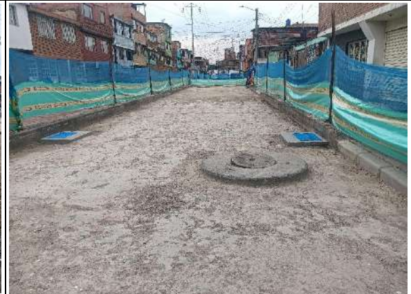
Instalación y compactación de base granular estabilizada
