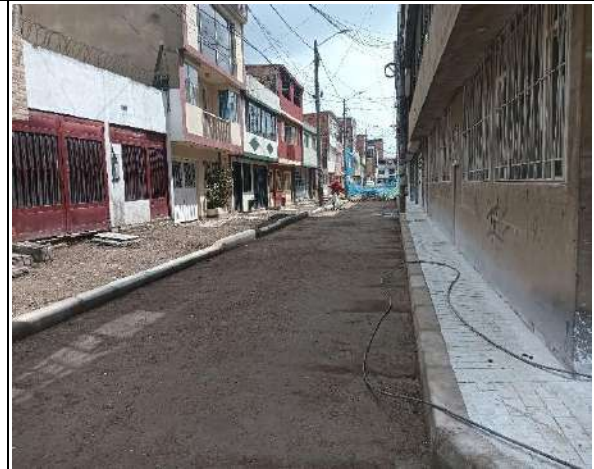
Instalación y nivelación de base estabilizada
