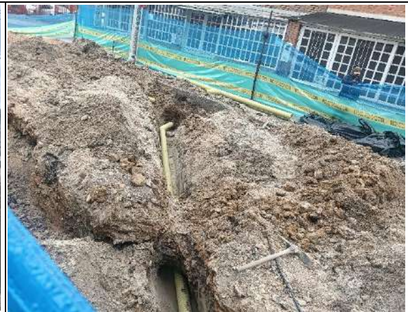
Renovación de red sanitaria
