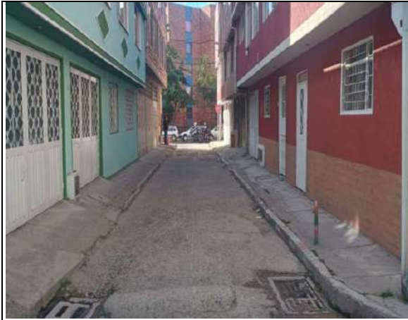
Estado actual del frente de obra
