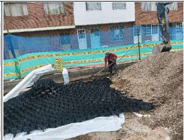
Instalación de geocelda y su lleno
