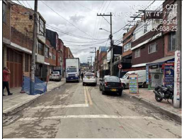
Estado actual del frente de obra
