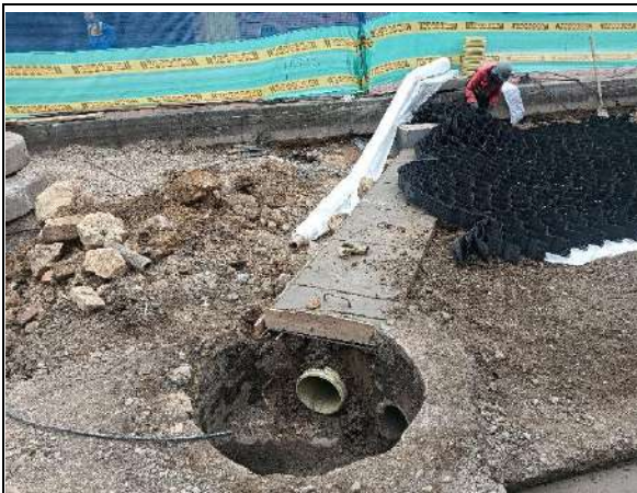
Construcción de cárcamo para protección de red pluvial
