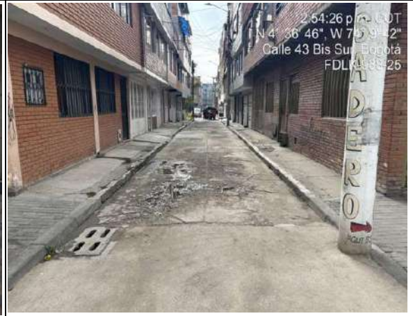
Estado actual del frente de obra
