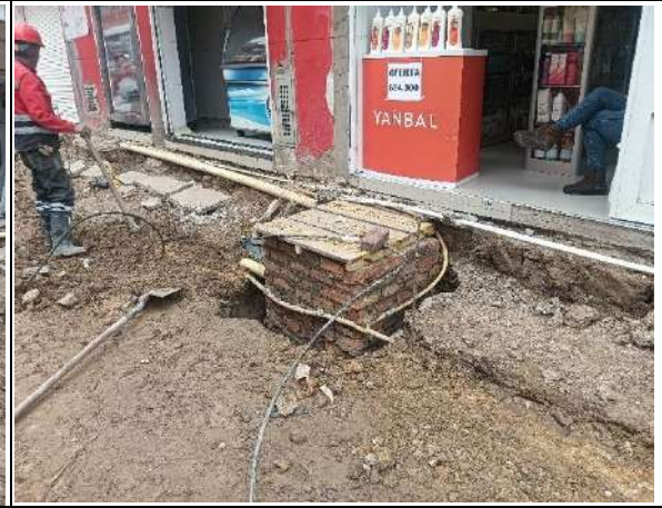
Construcción de cajas de inspección
