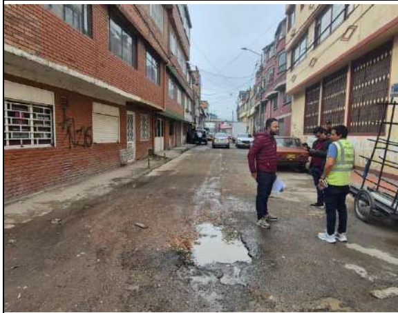
Estado actual del frente de obra
