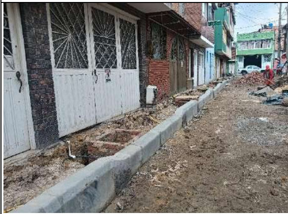
Instalación de prefabricados
