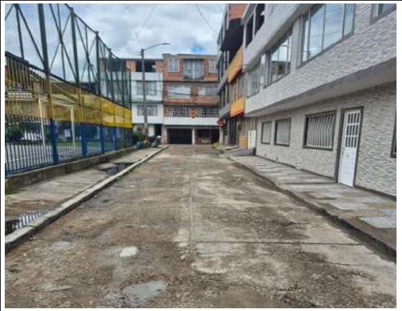
Estado actual del frente de obra
