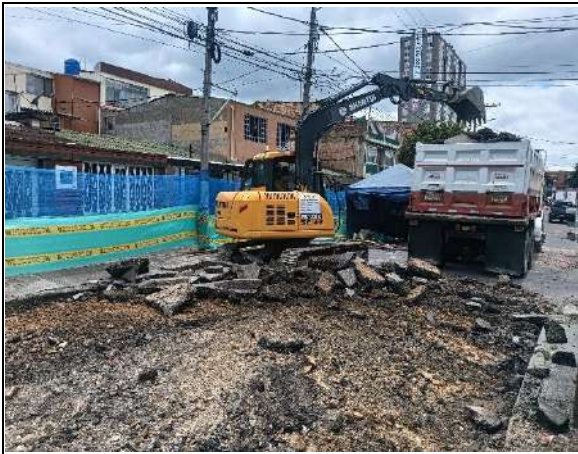
Demolición de carpeta asfáltica
