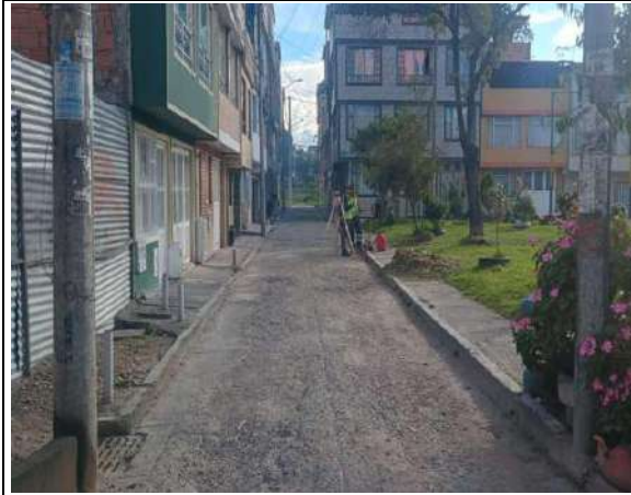
Estado actual del frente de obra
