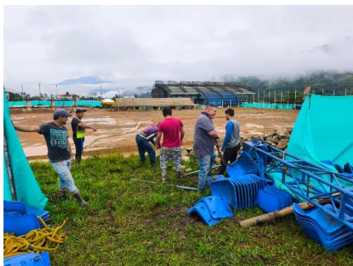
Montaje e instalación de carpa
