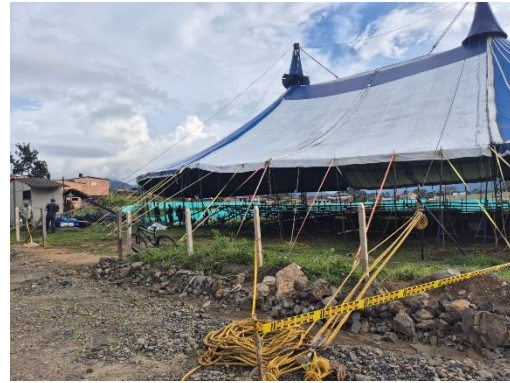
Montaje e instalación de carpa
