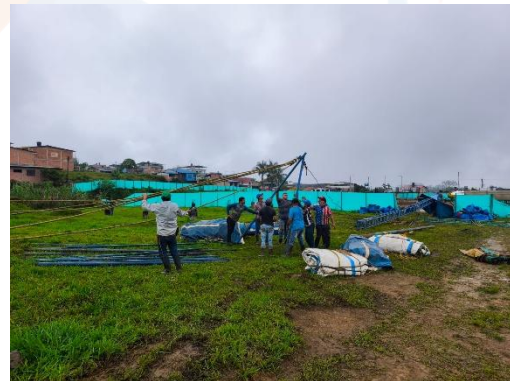
Montaje e instalación de carpa
