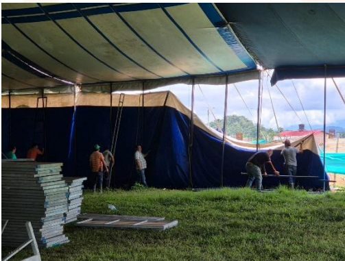
Montaje e instalación de carpa
