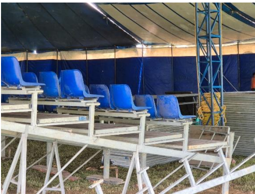
Montaje e instalación de silletería
