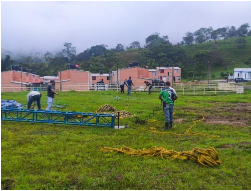
Montaje e instalación de carpa
