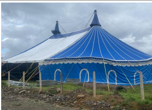
Montaje e instalación de carpa
