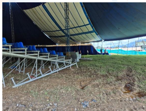
Montaje e instalación de carpa
