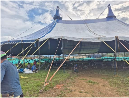
Montaje e instalación de carpa
