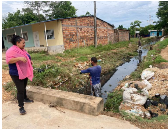
Evidencia fotográfica 44. Tramo caño Belén intervención retiro de material vegetal y sedimento en el barrio La Concepción
