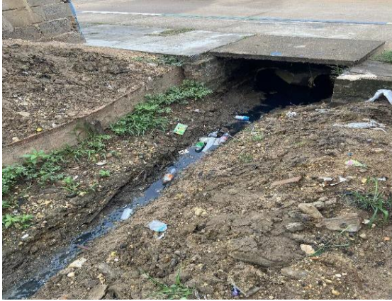
Evidencia fotográfica 23. Tramo caño Chofly estado inicial barrio Nuevo
