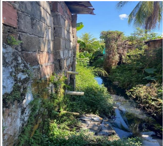
Evidencia fotográfica 32. Tramo caño Belén estado inicial del caño barrio Belén
