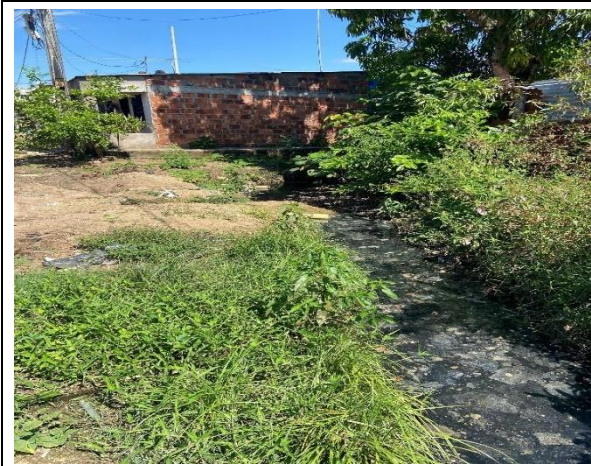
Evidencia fotográfica 29. Tramo caño Belén estado inicial del caño barrio Belén
