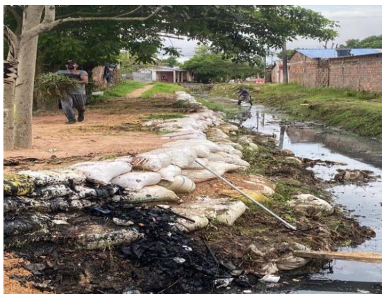
Evidencia fotográfica 42. Tramo caño Belén intervención retiro de material vegetal y sedimento en el barrio San José
