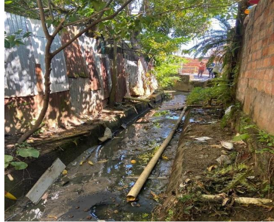
Evidencia fotográfica 34. Tramo caño Belén
