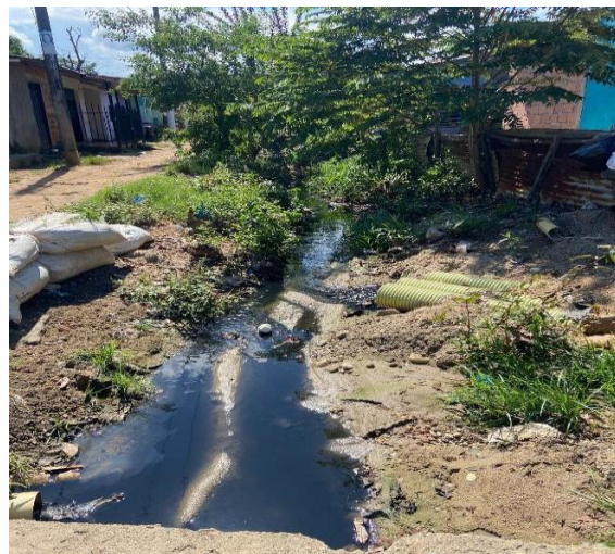
Evidencia fotográfica 31. Tramo caño Belén estado inicial del caño barrio Belén
