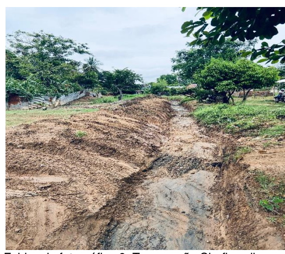
Evidencia fotográfica 8. Tramo caño Chofly calle central retiro de sedimentos en el barrio San Jorge
