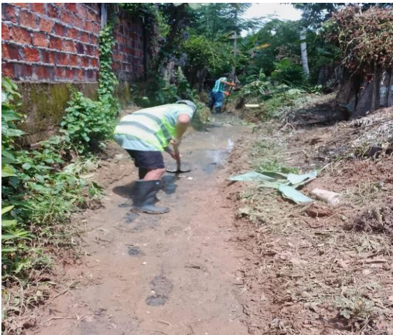
Evidencia fotográfica 11. Tramo caño Chofly calle parte traseras de viviendas en el barrio San Jorge retiro de sedimentos
