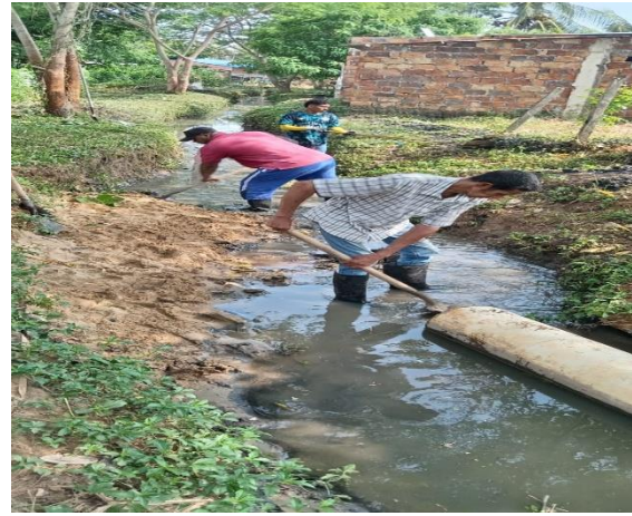
Evidencia fotográfica 14. Tramo caño Chofly supervisión retiro de sedimentos en el barrio La Paz
