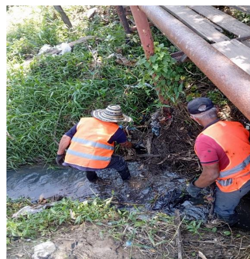
Evidencia fotográfica 22. Tramo caño Chofly trabajo retiro manual de material sedimentado en el barrio La Victoria
