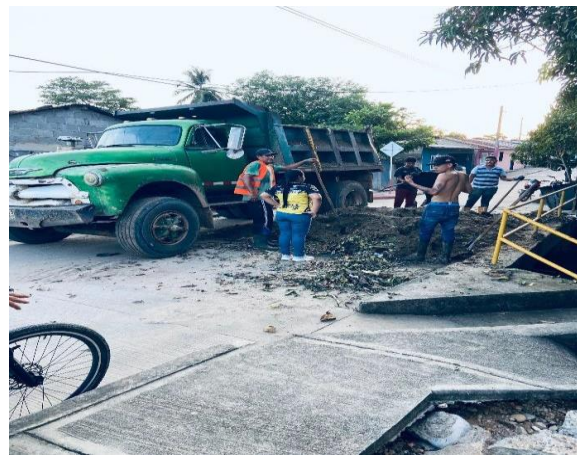
Evidencia fotográfica 36. Tramo caño Belén supervisión de recolección de residuos barrio Belén
