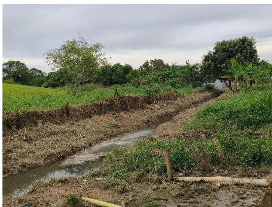
Evidencia fotográfica 62. Intervención finalizada caño Colorado barrio El Bosque
