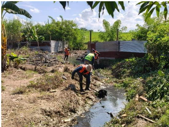
Evidencia fotográfica 59. Intervención manual retiro material sedimentos caño Colorado barrio El Bosque
