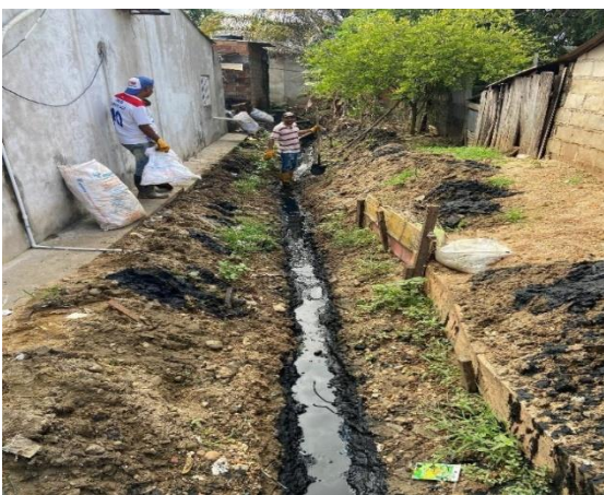
Evidencia fotográfica 25. Tramo caño Chofly trabajo manual de sacos rellenos para la protección del canal
