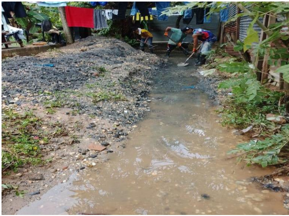
Evidencia fotográfica 9. Tramo caño Chofly calle parte traseras de viviendas en el barrio San Jorge retiro de sedimentos
