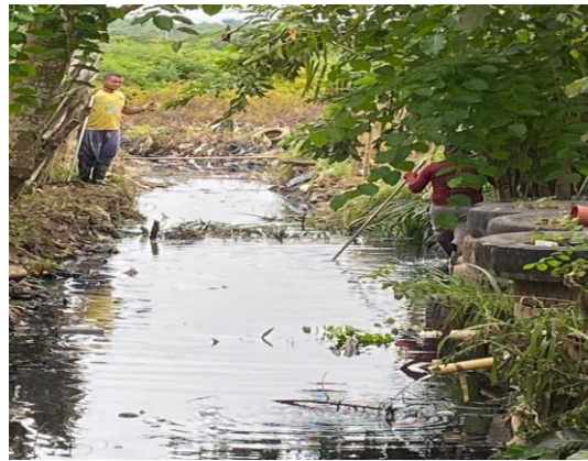
Evidencia fotográfica 45. Tramo caño Belén intervención retiro de material vegetal y sedimento sector final que conecta con el barrio el Porvenir
