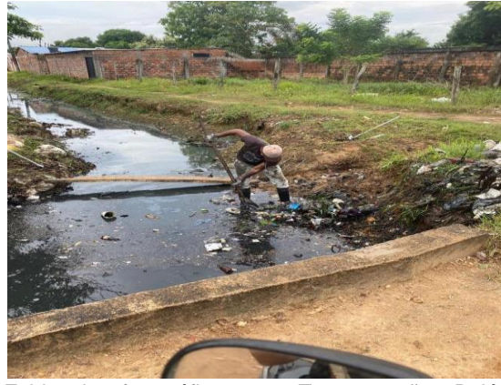
Evidencia fotográfica 40. Tramo caño Belén intervención manual retiro de material desechable y maleza
