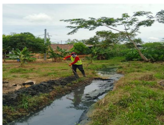
Evidencia fotográfica 54. Trabajo retiro de sedimentos caño Colorado barrio Nueve de marzo
