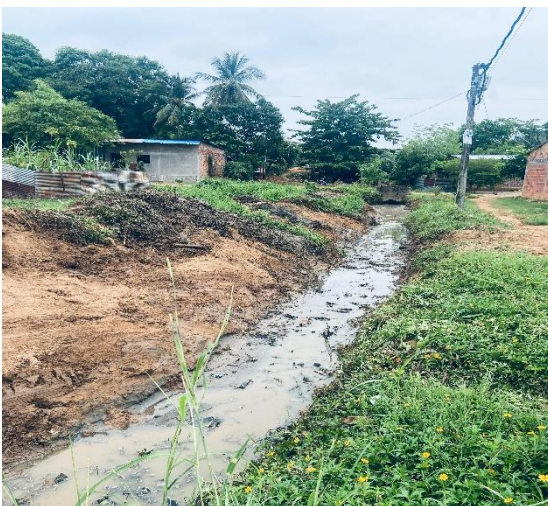
Evidencia fotográfica 7. Tramo caño Chofly calle central retiro de sedimentos en el barrio San Jorge
