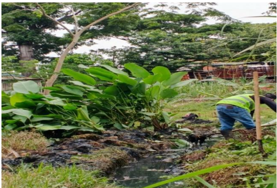
Evidencia fotográfica 55. Trabajo retiro de material vegetal caño Colorado barrio Nueve de marzo
