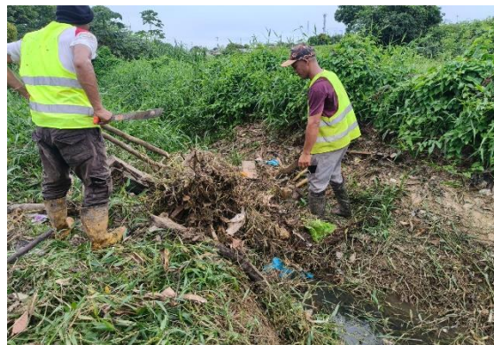
Evidencia fotográfica 61. Intervención retiro manual material vegetal caño Colorado barrio El Bosque
