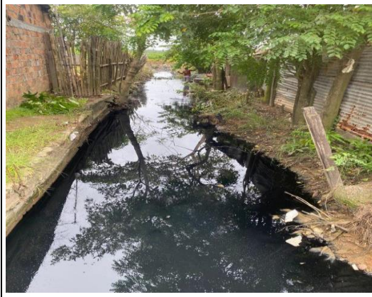
Evidencia fotográfica 46. Tramo caño Belén intervención retiro de material vegetal y sedimento sector final que conecta con el barrio el Porvenir
