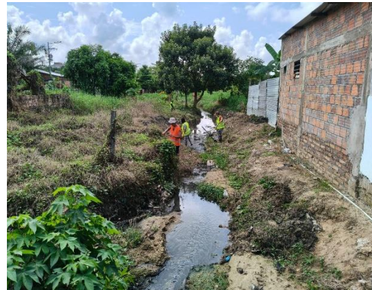
Evidencia fotográfica 60. Intervención manual retiro material sedimentos caño Colorado barrio El Bosque
