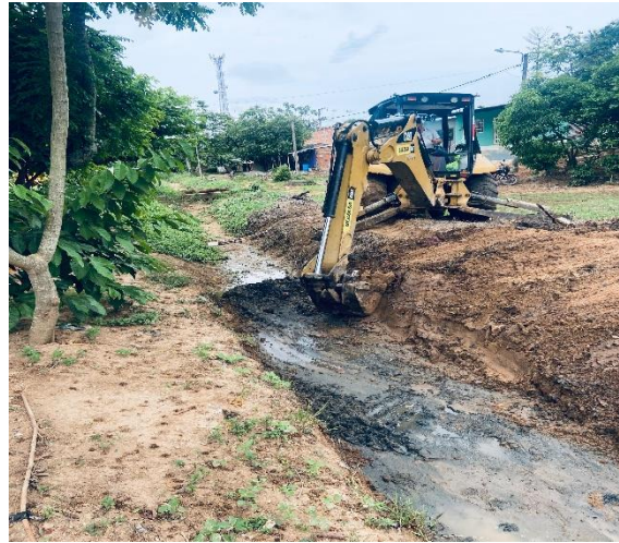
Evidencia fotográfica 6. Tramo caño Chofly calle central retiro de sedimentos en el barrio San Jorge
