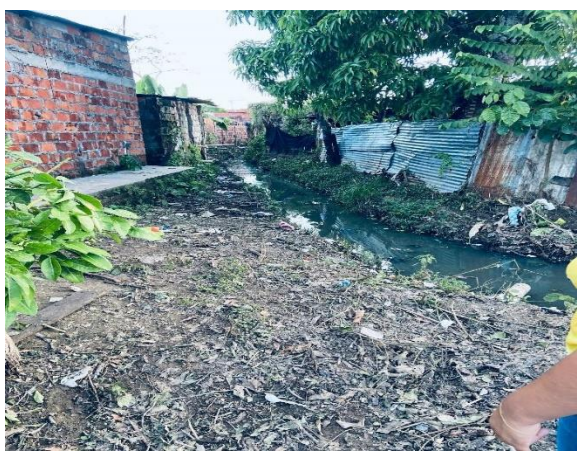
Evidencia fotográfica 38. Tramo caño Belén supervisión de obra
