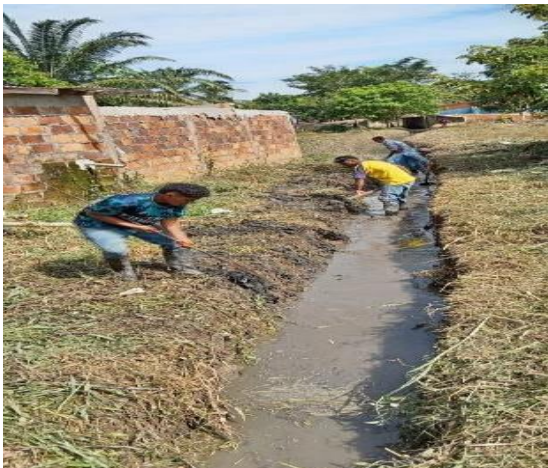
Evidencia fotográfica 69. Intervención manual caño Caguán barrio Las Ferias
