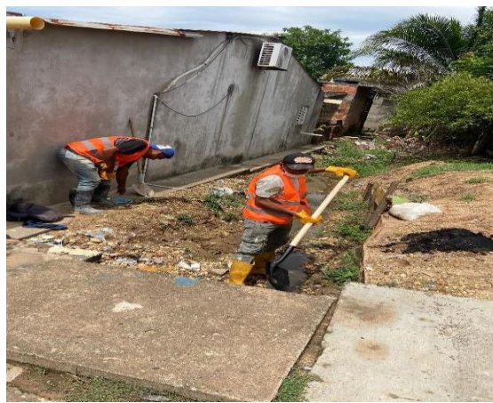
Evidencia fotográfica 26. Tramo caño Chofly trabajo manual de retiro de sedimento barrio Nuevo
