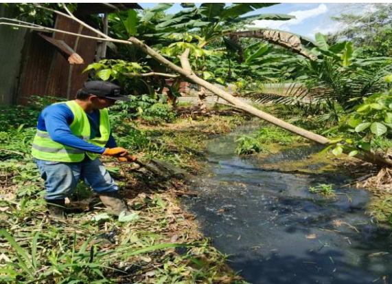
Evidencia fotográfica 53. Trabajo retiro de material vegetal caño Colorado barrio Nueve de marzo
