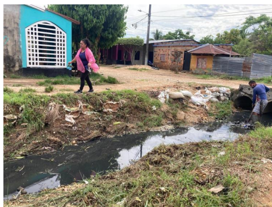
Evidencia fotográfica 43. Tramo caño Belén intervención retiro de material vegetal y sedimento en el barrio La Concepción
