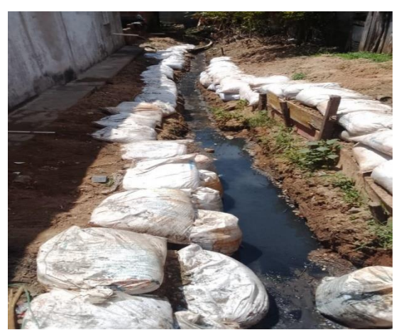
Evidencia fotográfica 28. Tramo caño Chofly barrio Nuevo – Barrera para protección
