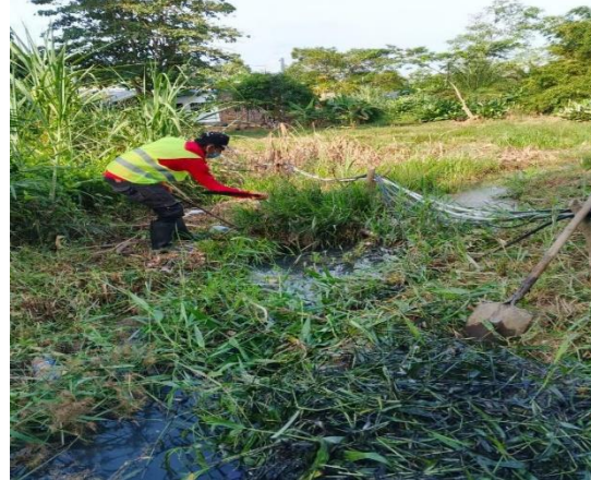
Evidencia fotográfica 52. Trabajo retiro de material vegetal caño Colorado barrio Nueve de marzo
