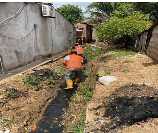
Evidencia fotográfica 27. Tramo caño Chofly retiro manual de sedimentos barrio Nuevo
