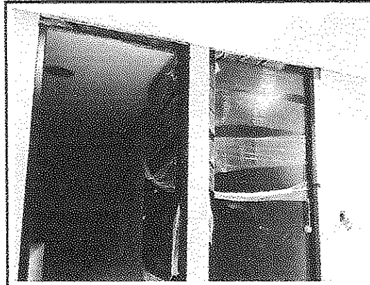
INSTALACIÓN DE PUERTAS EN LÁMINA COLD ROLLED ROLLED EN COCINA
