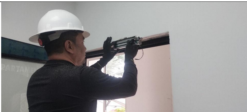
Imagen No. 22: ítem 31: sistema de apertura, electroimán
