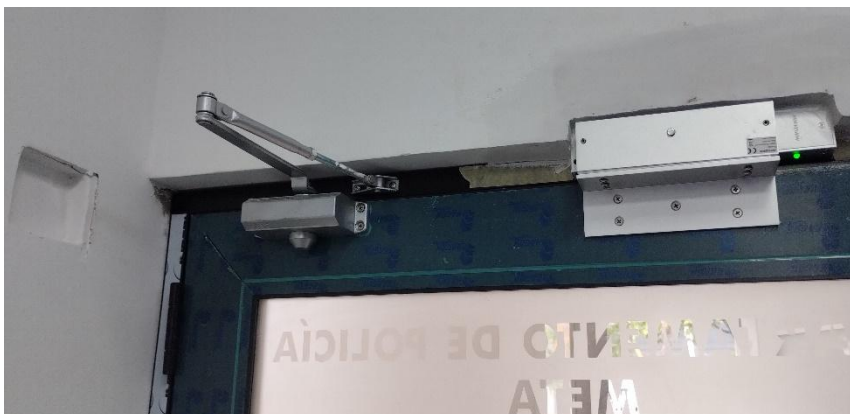
Imagen No. 23: Ítem 31: sistema de apertura, electroimán y brazo
