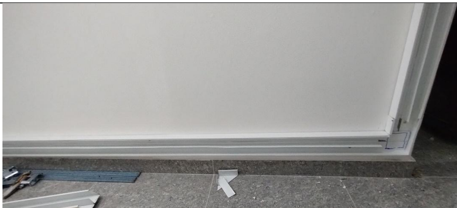
Imagen No. 2: adecuaciones de red
