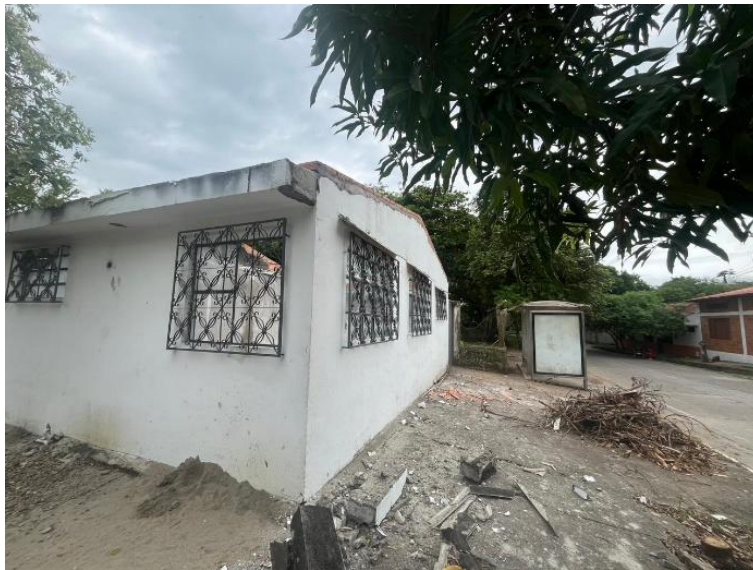
ALINEACION DE CUBIERTA Y RECALCE MUROS
