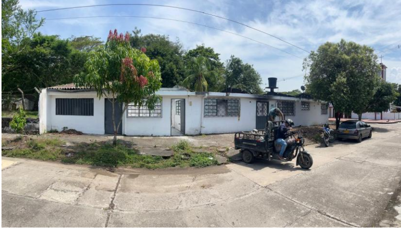
FACHADA FRONTAL, DESMONTE CUBIERTA ASBESTO CEMENTO
