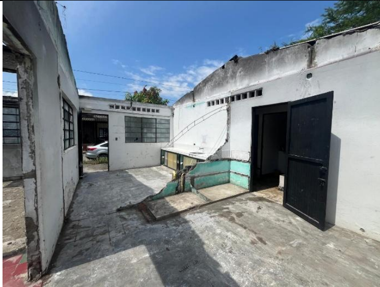
DEMOLICION MUROS EN MAMPOSTERIA
