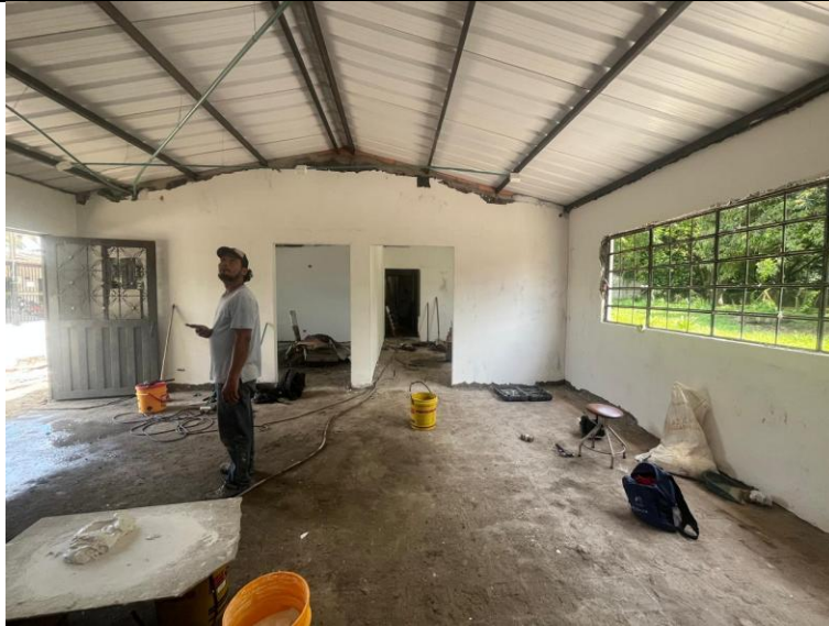
PEÑETE Y ESTUCO MUROS
