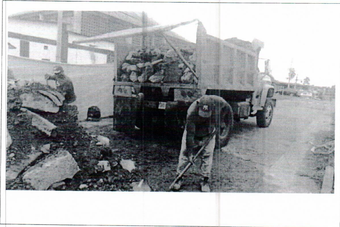
Cargue y retiro de material sobrante
