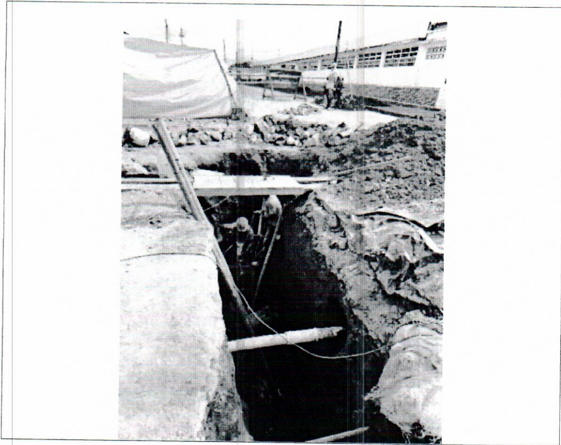
Demolición de base y cañuela
