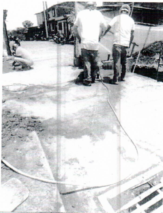
Corte de pavimento y andenes
