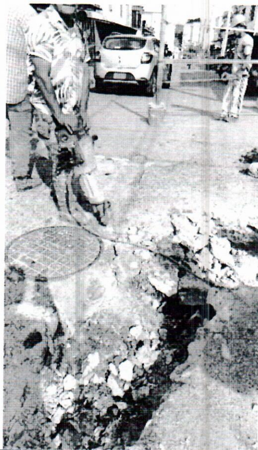
Demolición de pavimento y andenes
