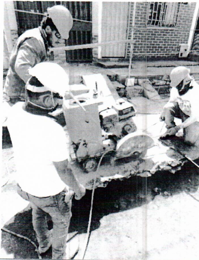
Corte de pavimento y andenes
