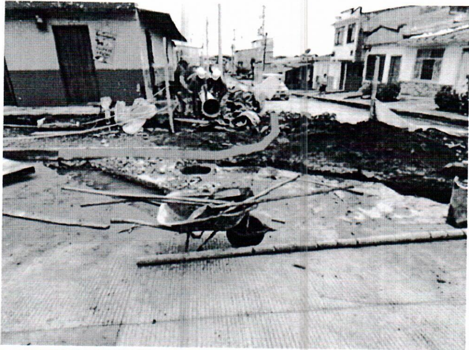
Demolición de sardinel frente a casa No.10-59
