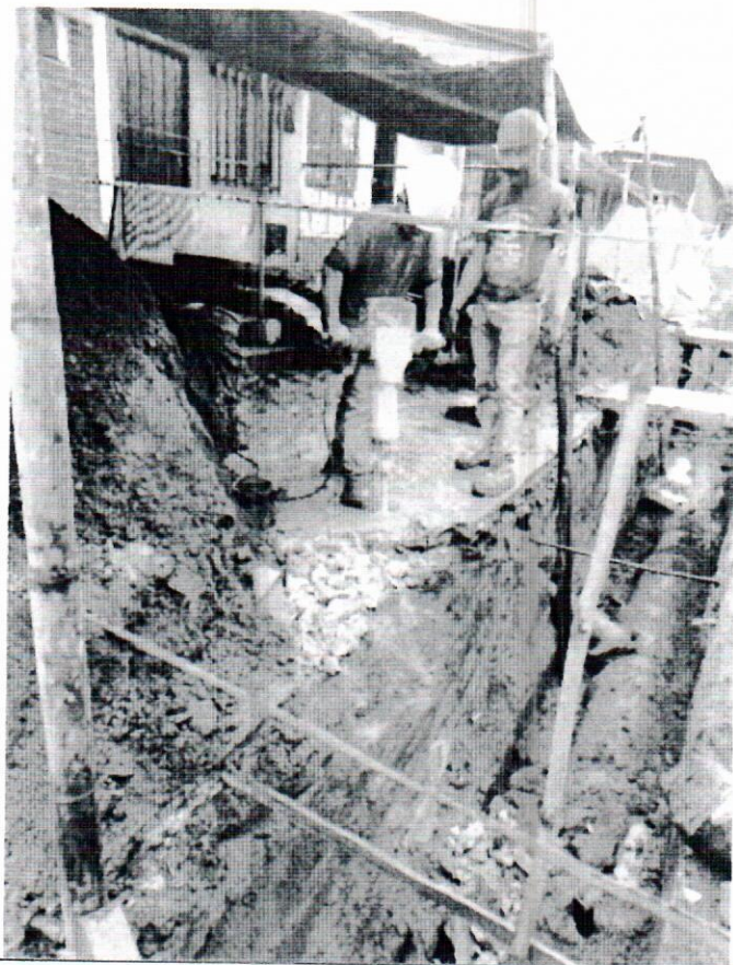
Demolición de pavimento y andenes
