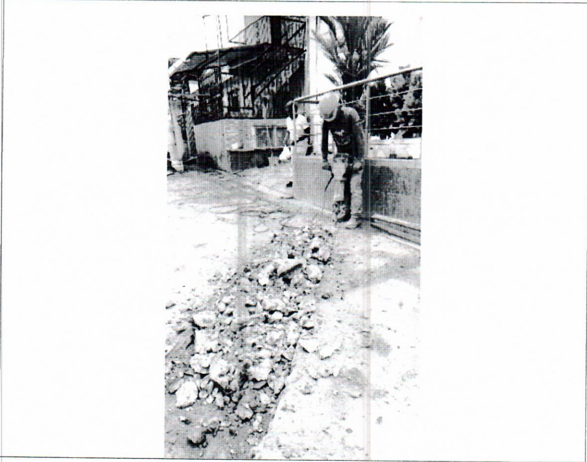
Demolición de pavimento
