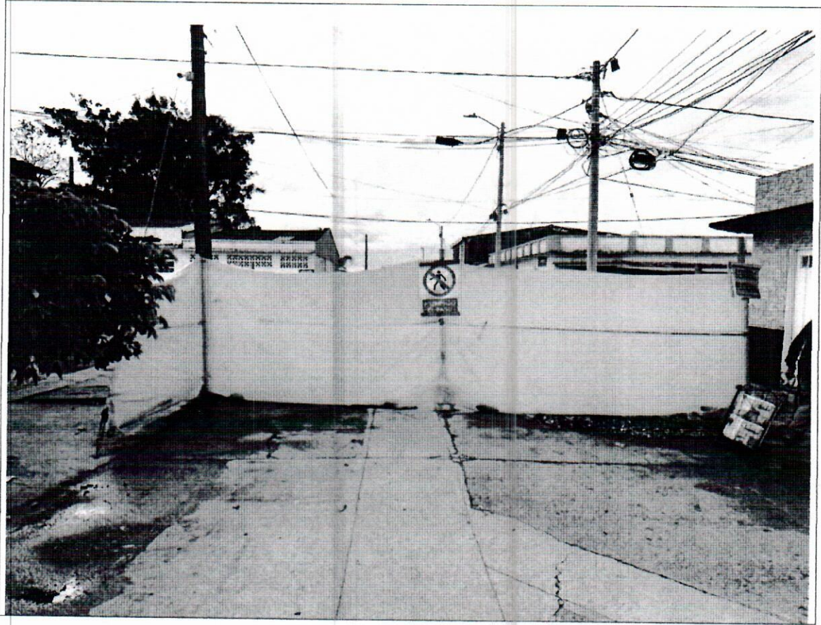
Señalización y cerramiento en obra
