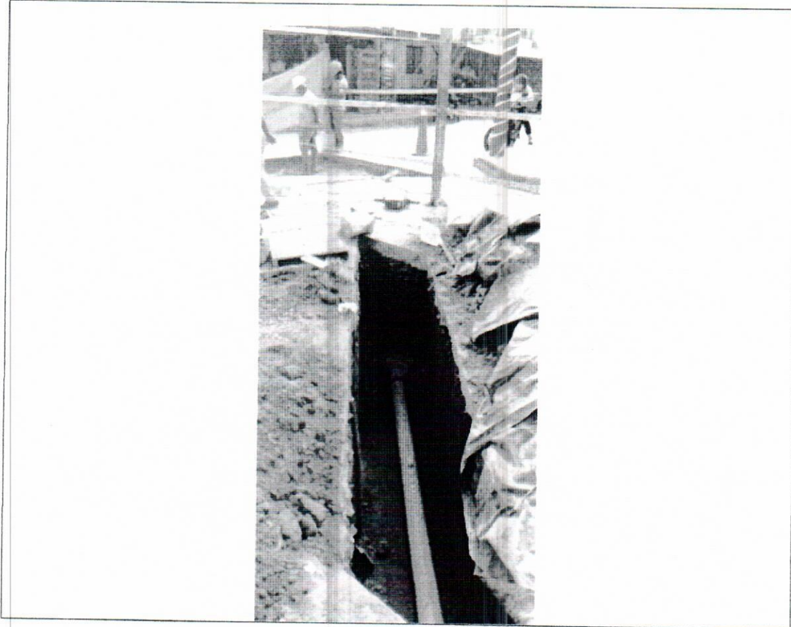
Tubería perfilada PVC de 6" y 20", y sillas Yee 20x6
