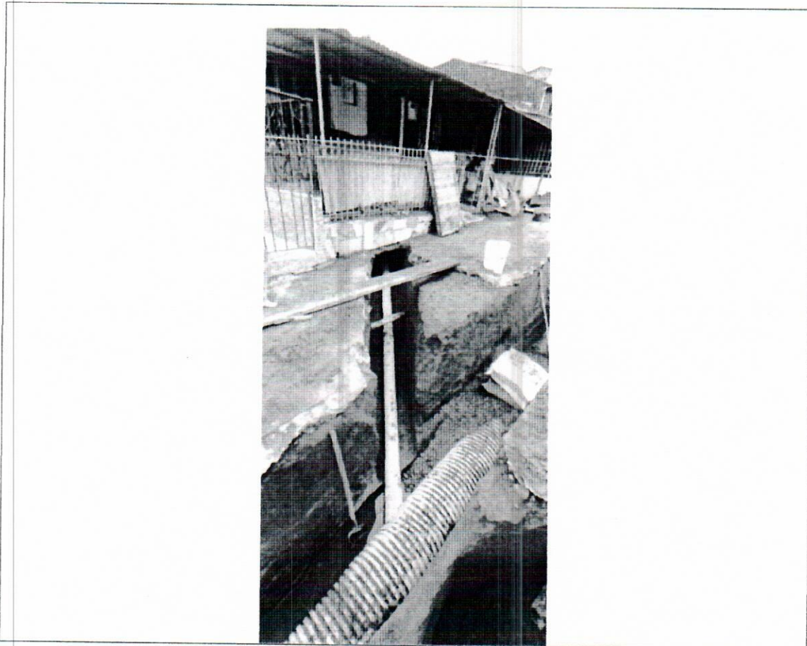
Tubería perfilada PVC de 6" y 20", y sillas Yee 20x6
