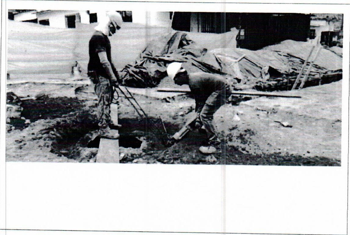
Demolición Cámara de alcantarillado
