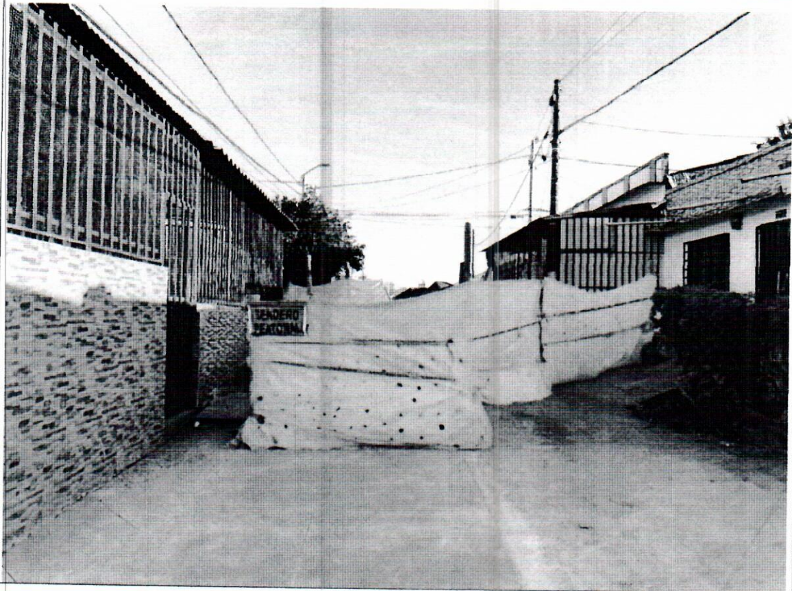
Señalización y cerramiento en obra
