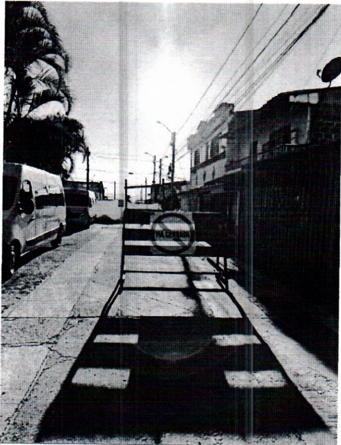
Señalización y cerramiento en obra
