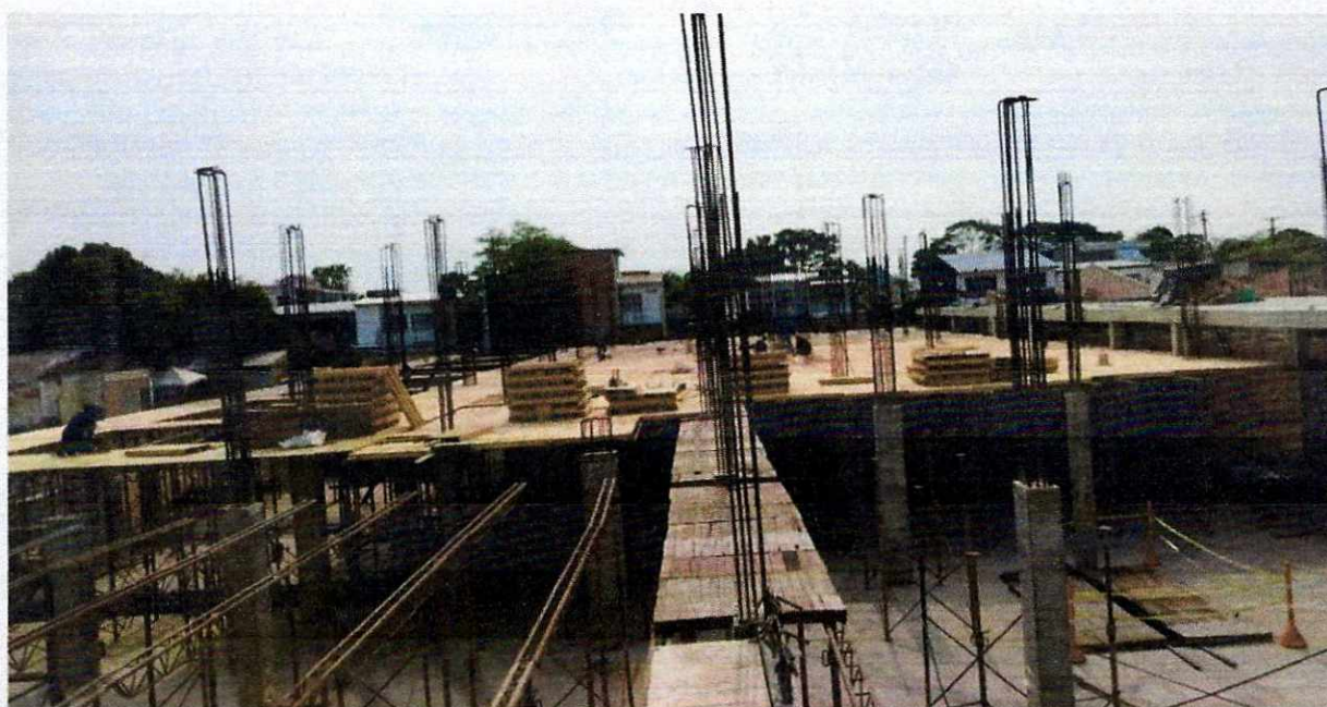
Formaleta para placa de entrepiso
