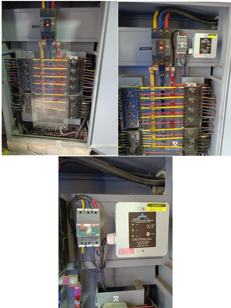
FIGURA 14 INSTALACION DPS EN TABLERO GENERAL DE DISTRIBUCION
