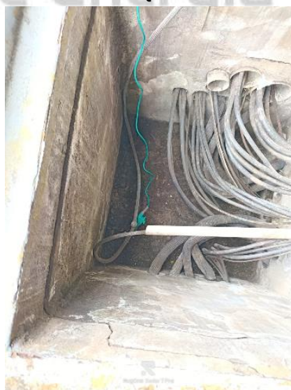
FIGURA 4 REGISTRO FOTOGRAFICO EQUIPOTENCIALIZACION SPT COLEGIO SAN AGUSTIN IED
