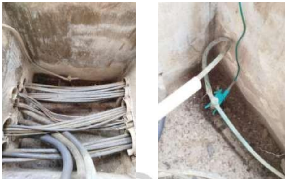
FIGURA 8 VARILLAS SPT COLEGIO SAN AGUSTIN IED
