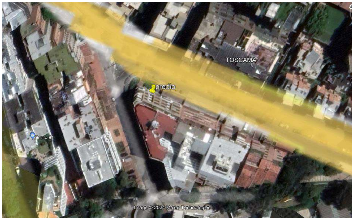
FIGURA 1. VISTA GENERAL DEL PROYECTO, PREDIO UBICADO EN AVENIDA CIRCUNVALAR CON CALLE 84
