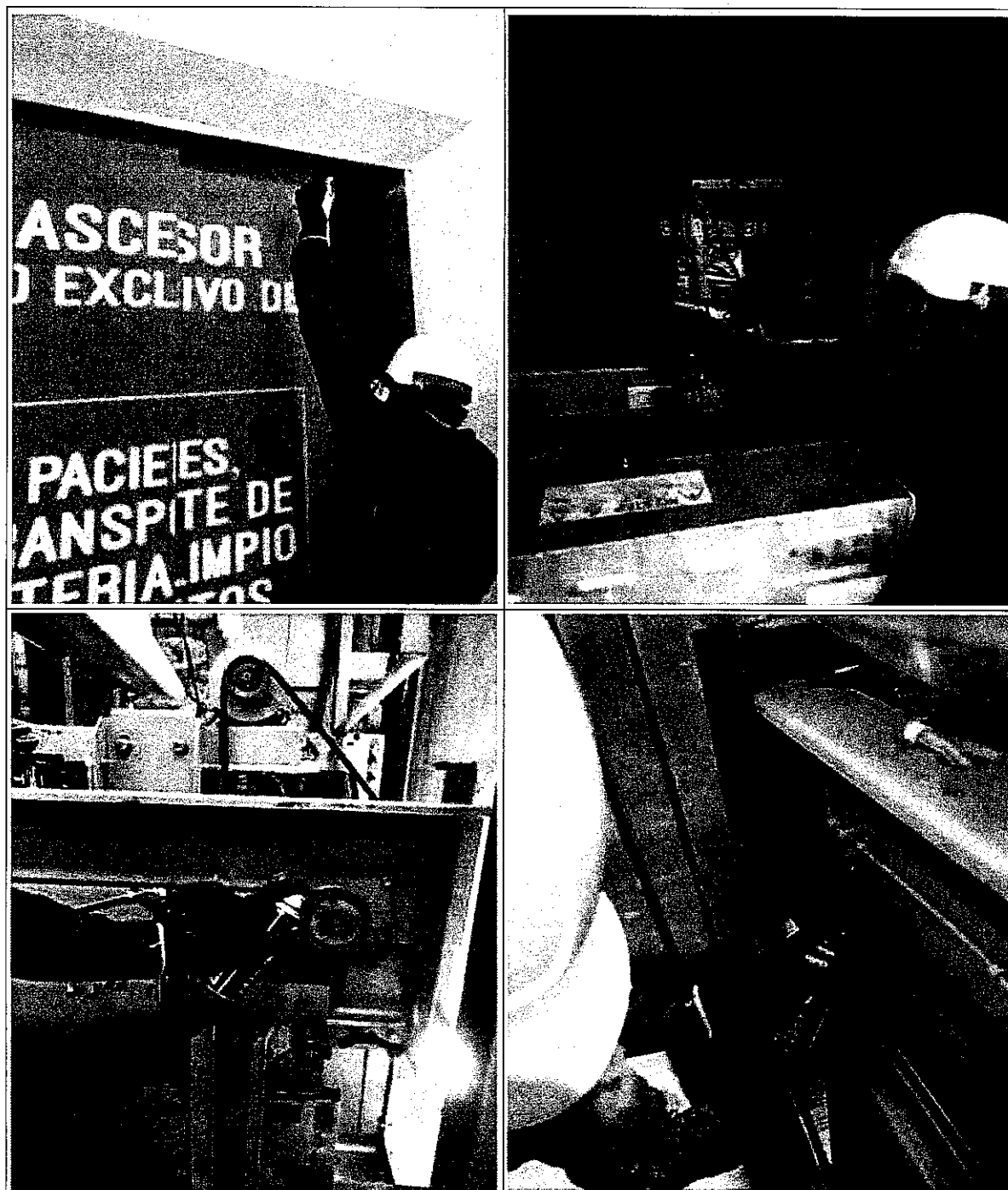
Ilustración 28: Mantenimiento preventivo y lubricación a cada uno de los mecanismos de apertura de puertas en cabina (abrir, cerrar) verificación del estado de las correas, guayas y resortes.
