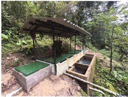
Imagen No.5. - se evidencia el desarrollo de actividades en el Desarenador
