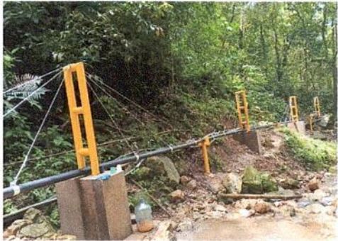
Imagen No. 3. - se evidencia el desarrollo de actividades en la Red de Aducción
