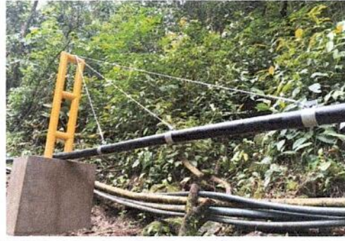
Imagen No. 2. - se evidencia el desarrollo de actividades en la Red de Aducción
