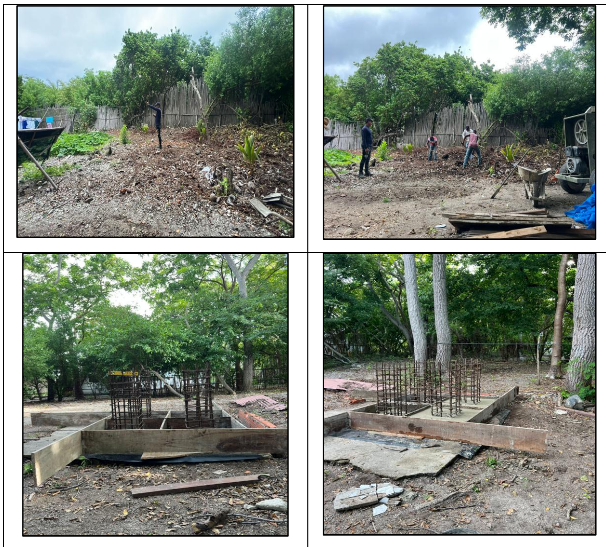
Imagen 30. Avance del mes de octubre – Caseta central de generación (18 paneles)
