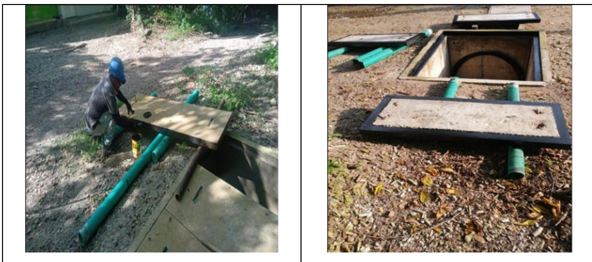
Imagen 41. Pintura de marcos de cajas MT 305 Y 405.
