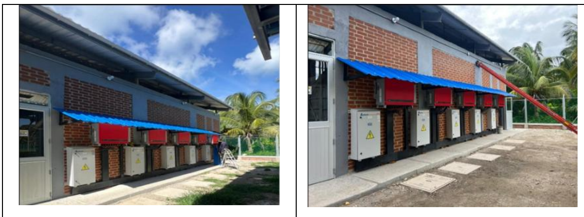
Imagen 33. Instalación de techo de inversores.
