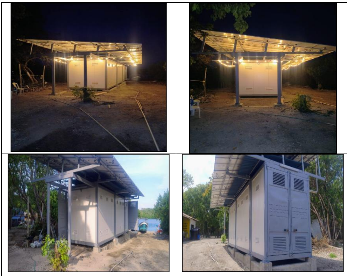
Imagen 31. Avance del mes de noviembre – Caseta central de generación (36 paneles)
