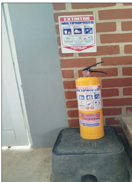
Imagen 8. Inspección de extintores.
