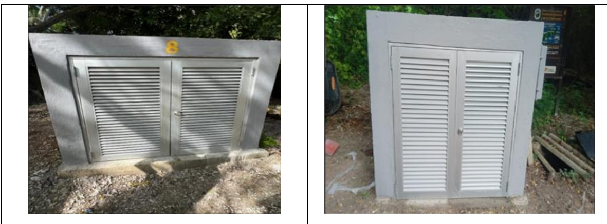
Imagen 39. Instalación de puertas en transformadores 6, 7, 8 y 9.
