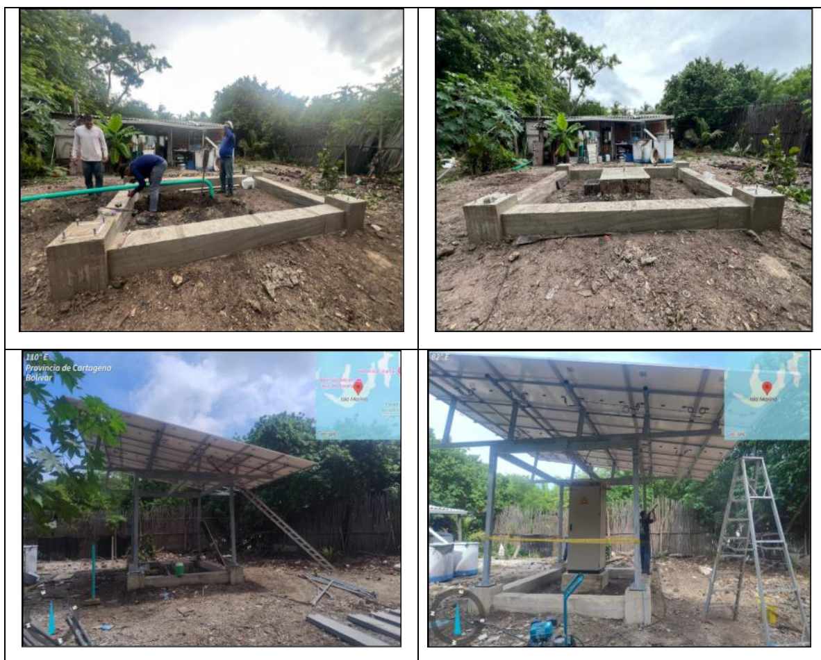
Imagen 32. Avance del mes de noviembre – Caseta central de generación (18 paneles)
