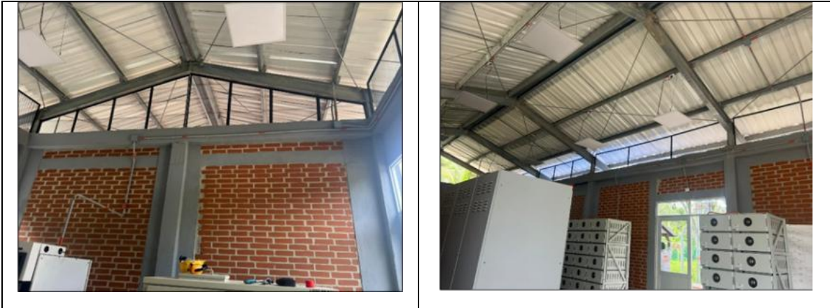
Imagen 34. Instalación de mallas contra aves en el cuarto de equipos.
