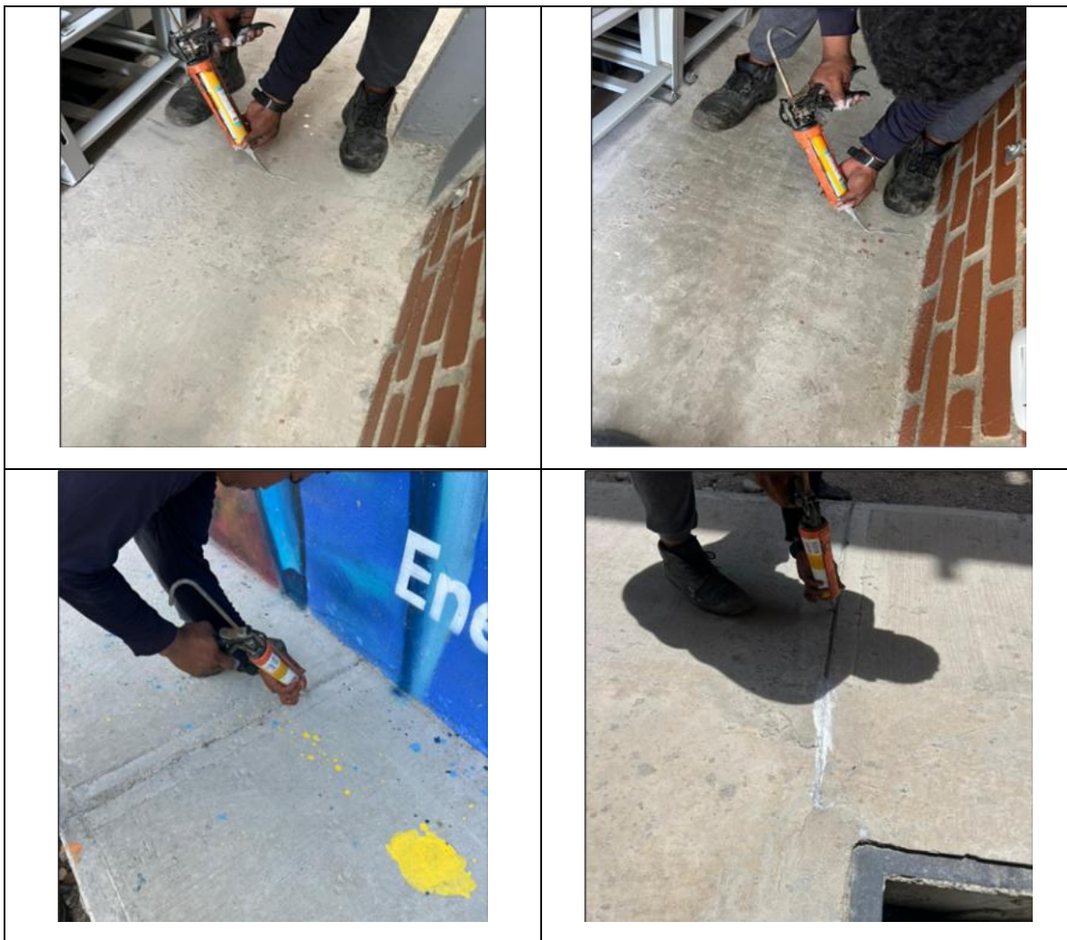
Imagen 36. Sellados de grietas en casetas de equipos.
