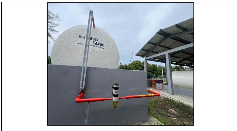
Imagen 28. instalación de la regla de medición del nivel de combustible en tanque principal
