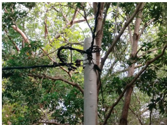
Imagen 47. Instalación redes de distribución en baja tensión en Isleta.
