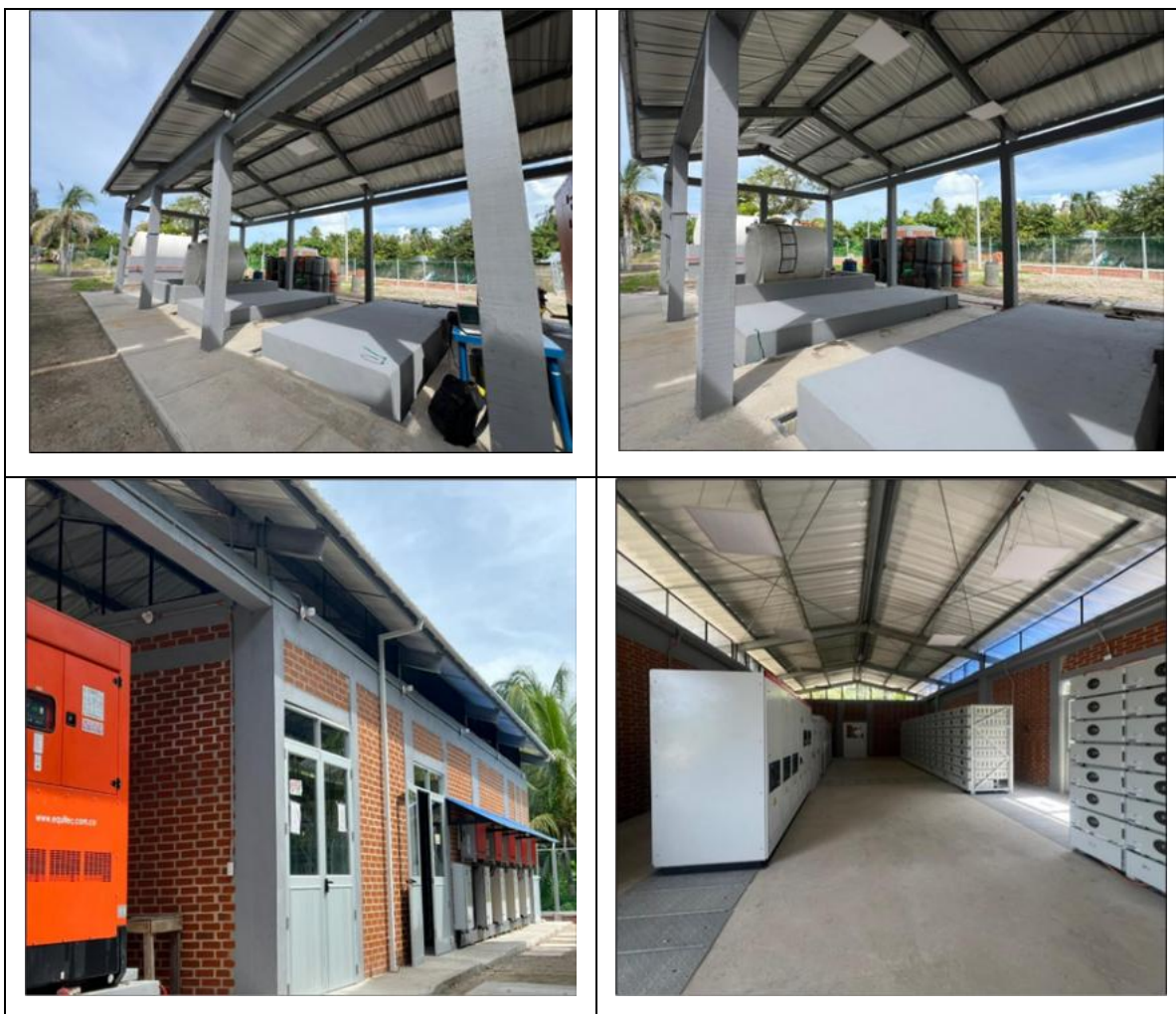
Imagen 37. Limpieza y retoque de pintura en caseta de equipos.
