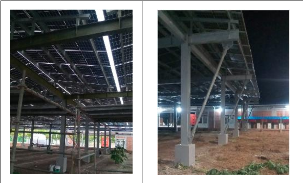
Imagen 48. Estructura del campo solar con esmalte aplicado y tornillería ajustada.
