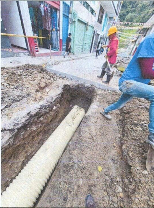
Descripción: instalación de tubería 24"
