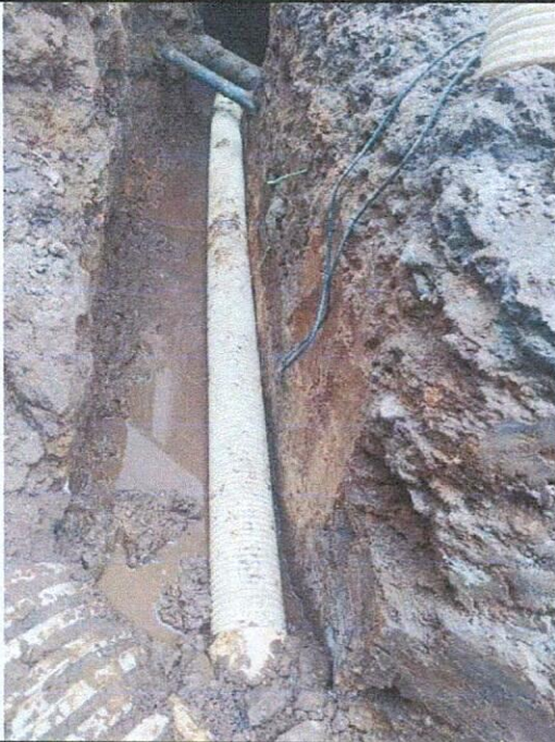
Descripción: instalación de tubería 6" Domiciliarias
