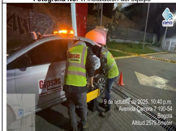
Fotografía No. 3. Instalación del equipo
