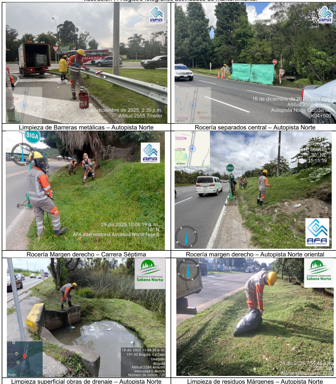
Limpieza superficial obras de drenaje – Autopista Norte
