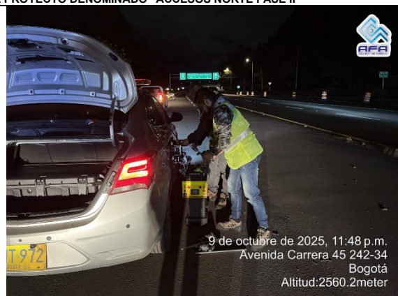
Fotografía No. 2. Instalación del equipo
