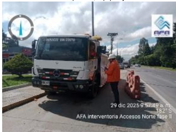
Fotografía N° 12. Revisión de maquinaria, equipos y vehículos – diciembre 2025
