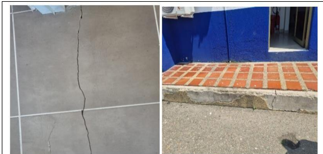
Ilustración 11 Estado de los pisos, superficies en mal estado con grietas y fisuras Fuente: propia
