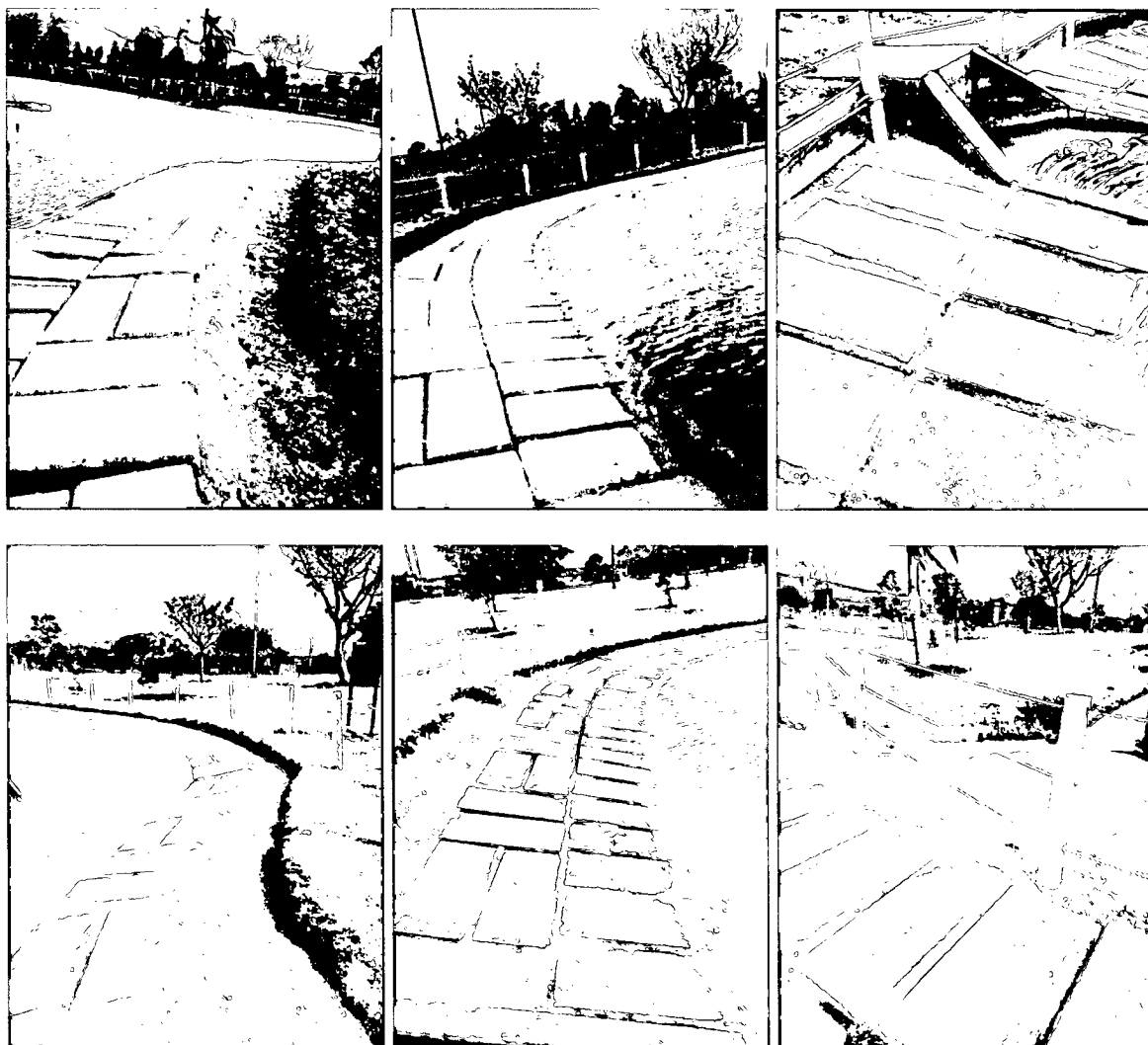
Figura 21. Losas de concreto instaladas y aseguradas con mortero, zonas estabilizadas y desagües adecuados para evitar acumulación de agua en el estanque Infantil.
