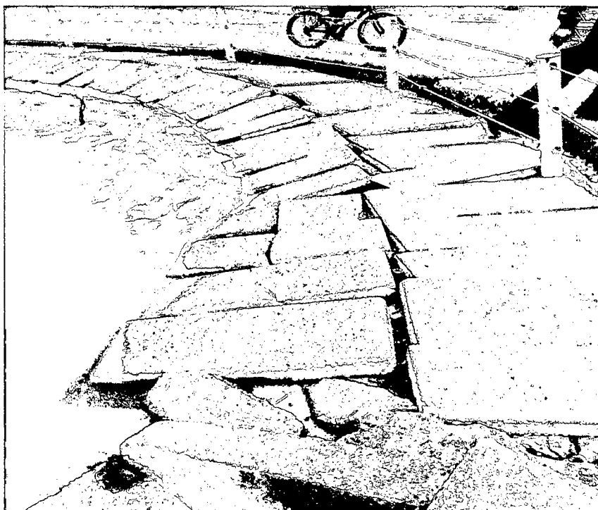
Figura 1. Estado de losas de concreto del estanque coliseo.
