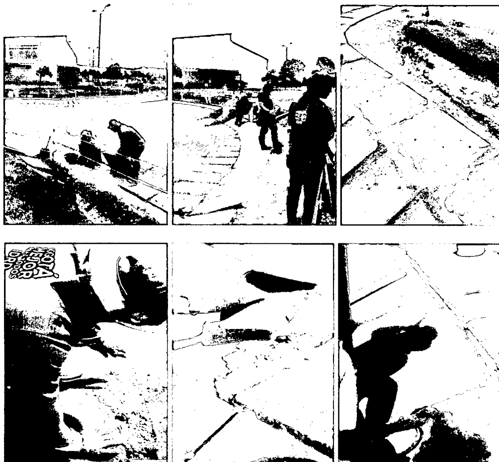
Figura 14. Reinstalación de losas de concreto en el estanque Coliseo.
