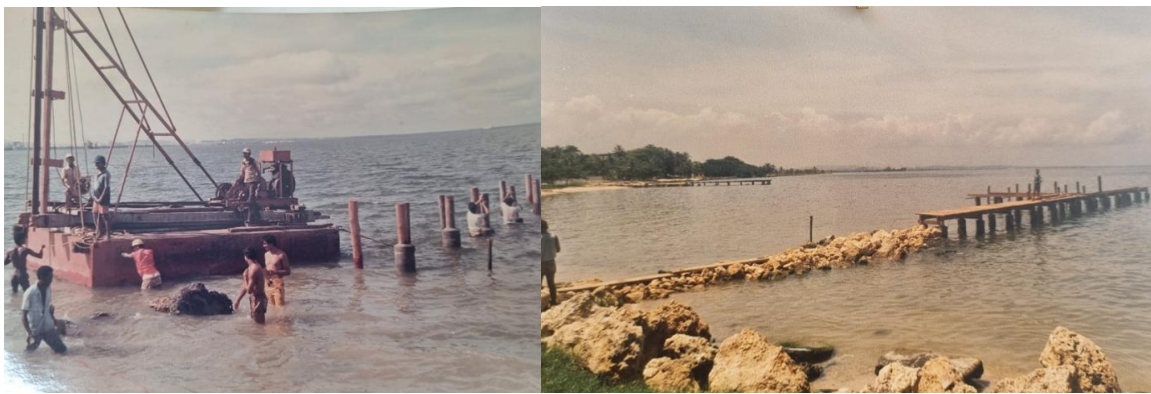
Ilustración 5 Fotos construcción muelle embarcaciones menores CIOH, agosto 1987. Fuente Biblioteca CIOH.
