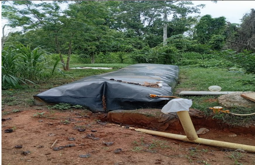
Foto 9. Biodigestor tipo bolsa con conexión hidráulica desde unidad porcina instalada y operativa
