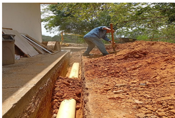
Foto 7. Tendido de tubería PVC Ø 4" en zanja con verificación de nivel
