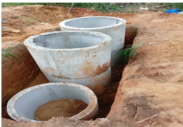
Foto 5. Anillos de concreto prefabricado posicionados en excavación para pozo séptico
