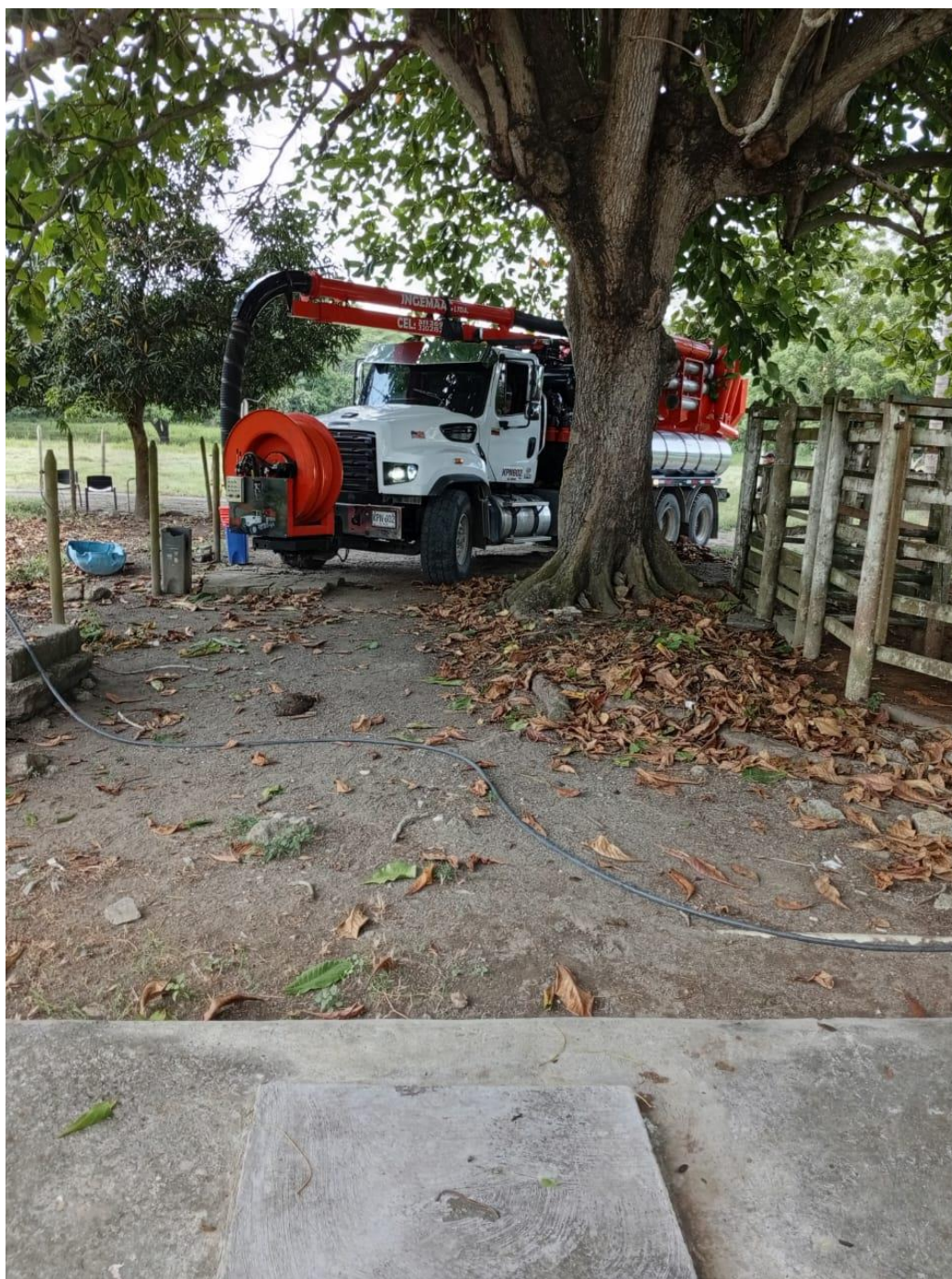
Fotografía 1. Ingreso y posicionamiento de camión de succión tipo Vector en área de intervención.
