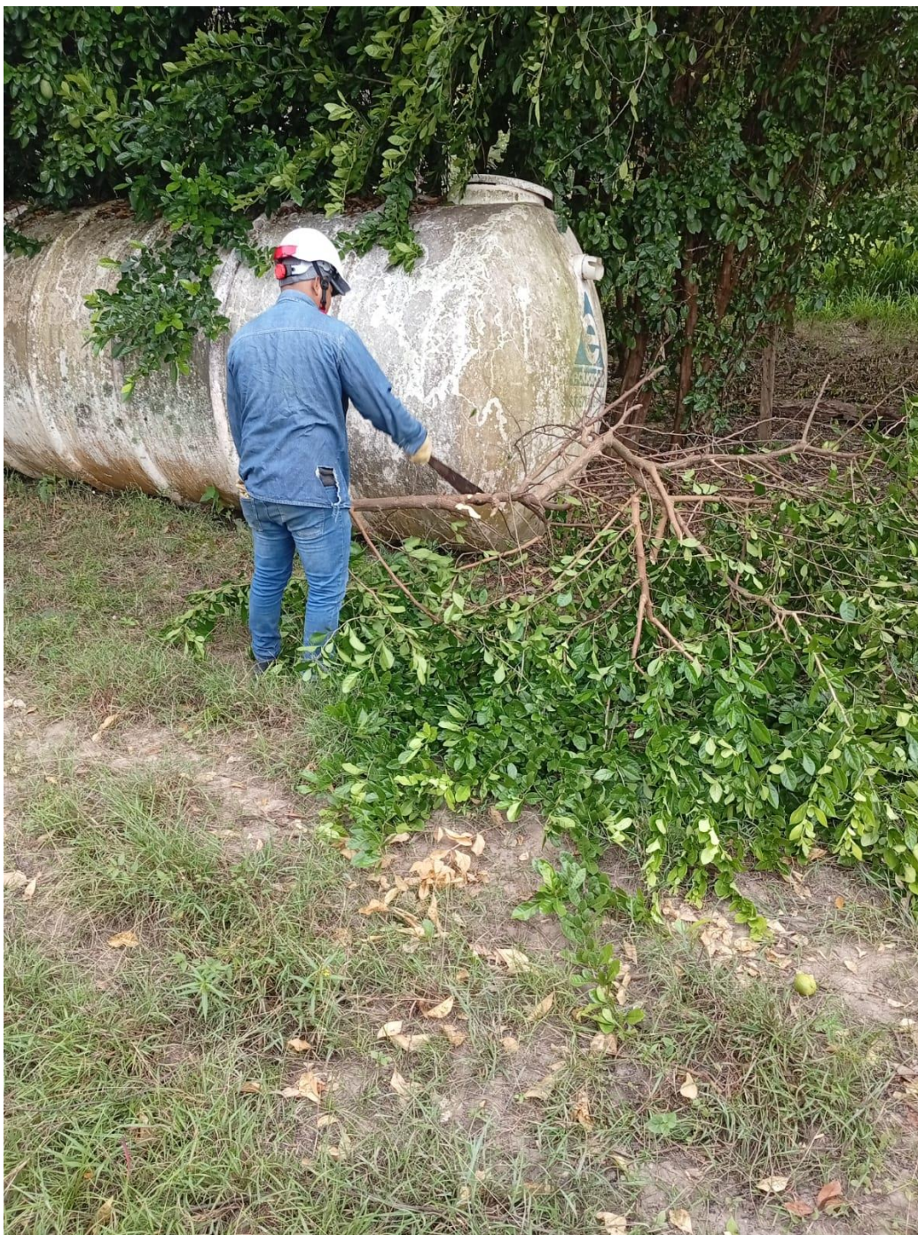
Fotografía 2. Personal operativo ejecutando labores de poda y mantenimiento en zona adyacente a estructura del sistema de saneamiento.
