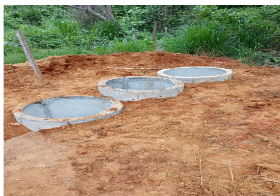
Foto 6. Vista superior – apilamiento y ensamble de anillos en campo
