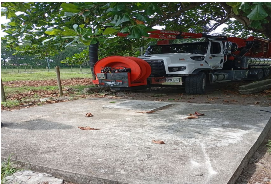
Foto 1. Camión Vactor INGEMAAC KPN-602 posicionado en área de la PTAR
