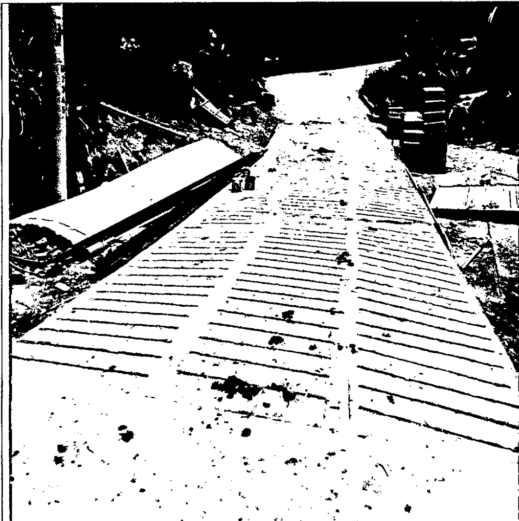
Fotografía 33: Acabado final del Placa huella de acceso.
