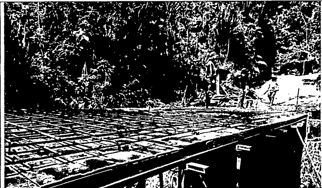
Fotografía 20: Armado de acero para tablero.
