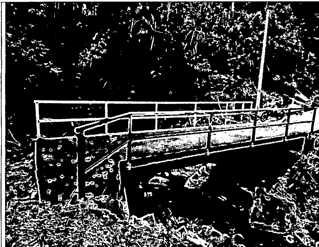
Fotografía 30: Acabado final del puente Pachondo.
