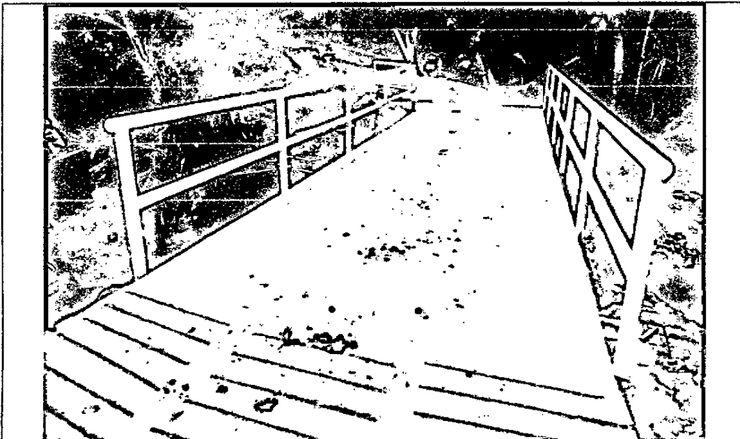
Fotografía 31: Acabado final del puente Pachondo.
