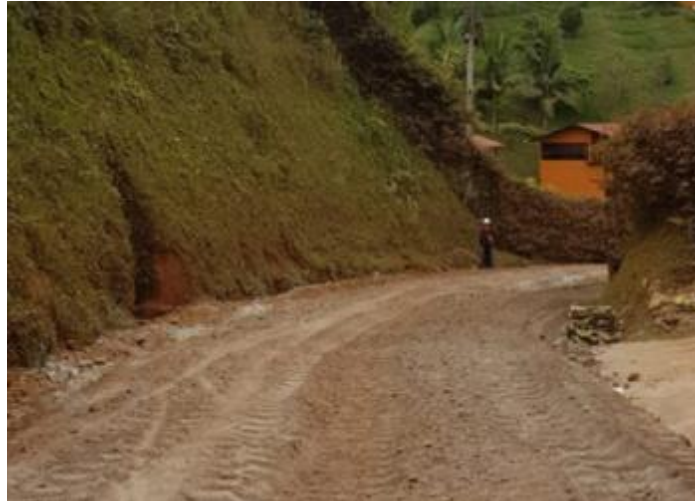
Ilustración 4. Acondicionamiento de la subrasante. Fuente: Cartilla 002 Argos
