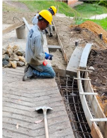
Ilustración 9. Fundición de cunetas en concreto Clase E. Fuente: Cartilla 002 Argos
