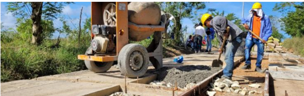
Ilustración 7. fundición con concreto Clase D. Fuente: Cartilla 002 Argos
