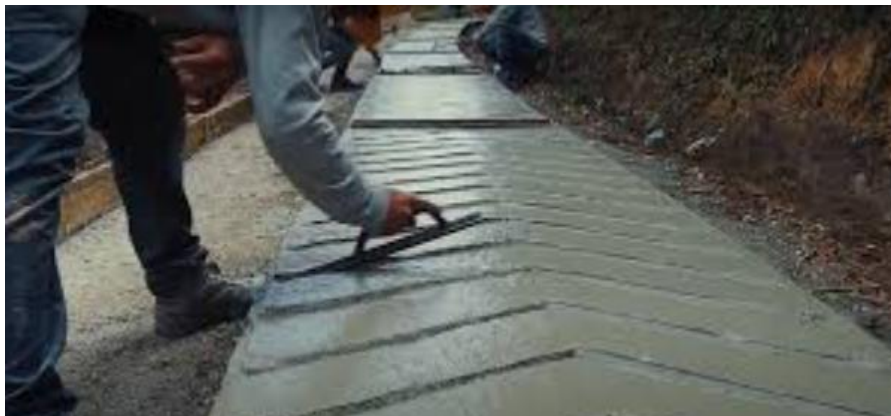
Ilustración 11. Estriado con diseño tipo espina de pescado. Fuente: Cartilla 002 Argos
