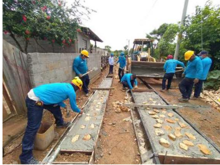
Ilustración 8. Fundición de concreto ciclópeo Clase G. Fuente: Cartilla 002 Argos
