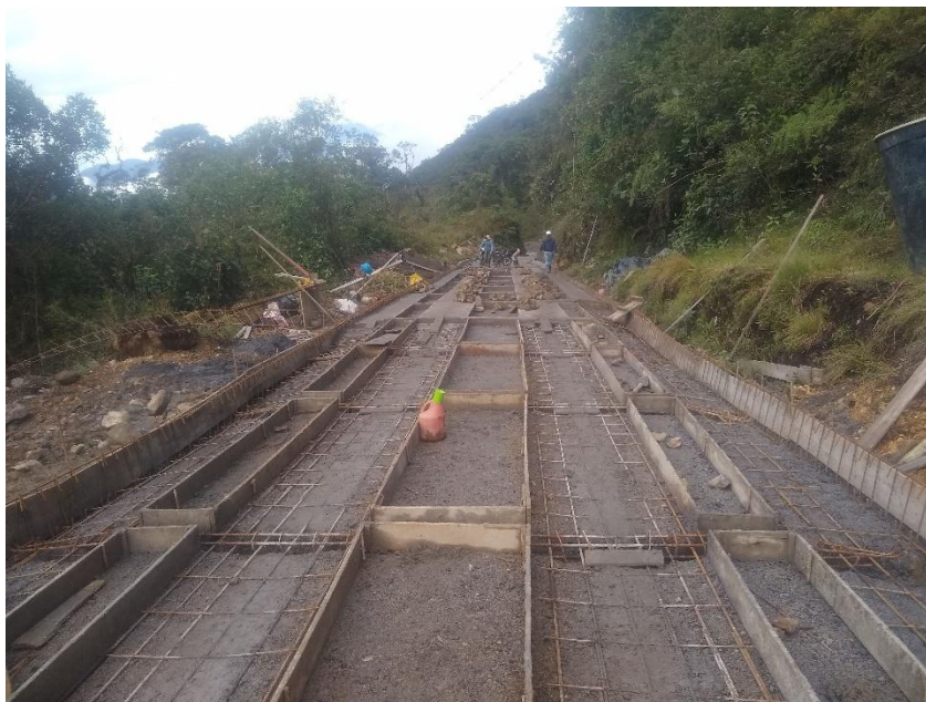
Ilustración 5. Colocación de formaleta. Fuente: Cartilla 002 Argos
