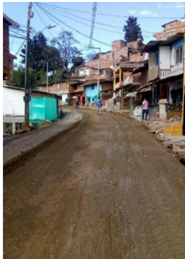
Ilustración 3. Acondicionamiento de la subrasante. Fuente: Cartilla 002 Argos
