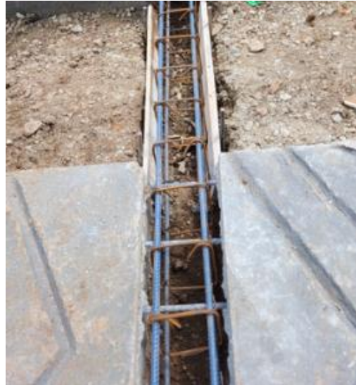
Ilustración 6. Colocación de hierro. Fuente: Cartilla 002 Argos
