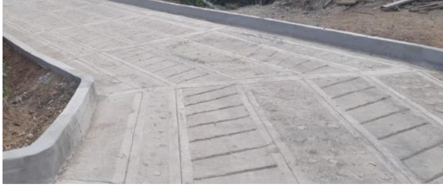
Ilustración 10. Construcción de Placa de Acceso. Fuente: Cartilla 002 Argos
