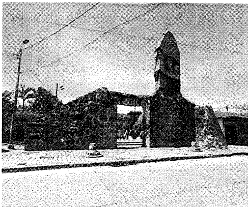
Fotografía N° 01 Estado actual Ruinas de Santa Lucía
