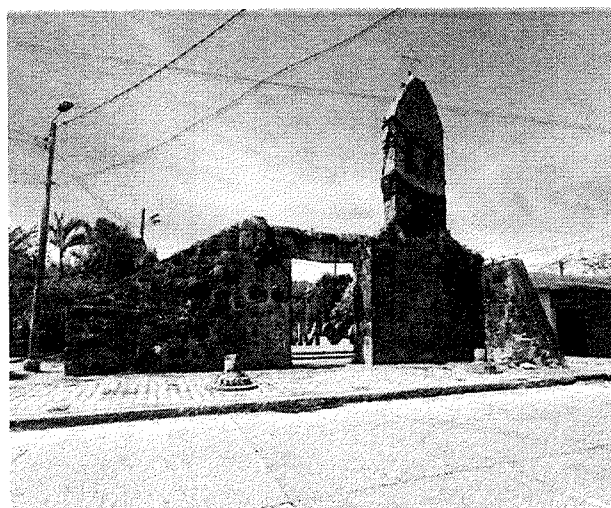
Fotografía N° 01 Estado actual Ruinas de Santa Lucía
