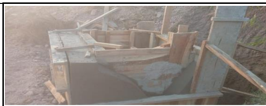
BARAYA: TRAMO BARAYA - LA TROJA - TROJA BAJA K0+500 / K3+300 / K16+100
