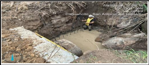
GARZON: TRAMO CAGUANCITO - SAN ANTONIO DEL PESCAO K07+100
