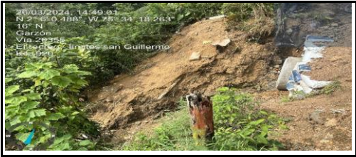
Garzón: TRAMO EL RECREO - LIMITE SAN GUILLERMO K1+700 / K1+920
