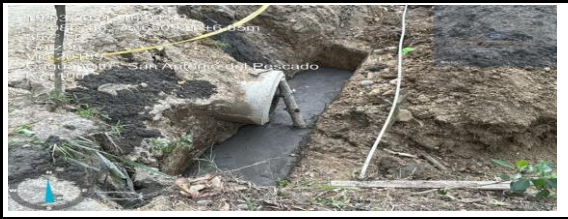
TUBERIA EN EL TRAMO - CAMPOALEGRE
