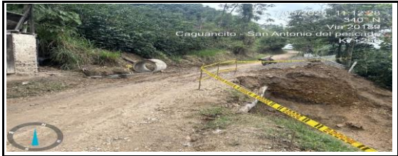
GARZON: TRAMO CAGUANCITO - SAN ANTONIO DEL PESCAO K07+100
