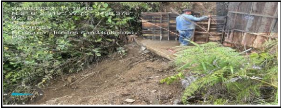
Garzón: TRAMO EL RECREO - LIMITE SAN GUILLERMO K1+700 / K1+920
