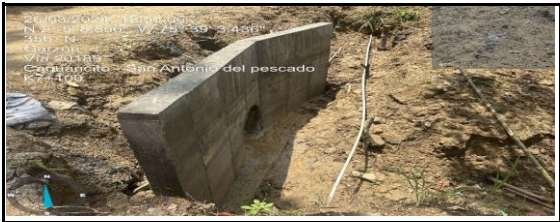
Garzón: TRAMO CAGUANCITO - SAN ANTONIO DEL PESCADO K7+100 / K7+250 / K7+900
