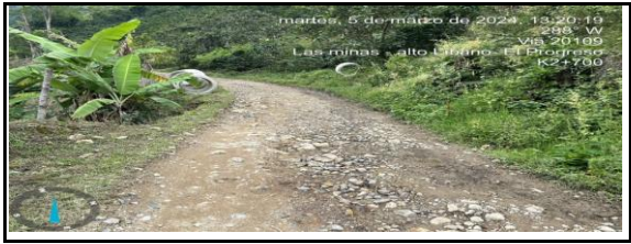
EL PITAL: LAS MINAS - ALTO LIBANO - EL PROGRESO K1+700 / K2+700
