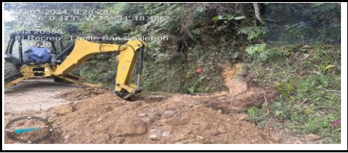
GARZON: TRAMO EL RECREO - LIMITE SAN GUILLERMO K1+700 / K1+920
