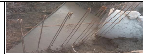
BARAYA: TRAMO BARAYA - LA TROJA - TROJA BAJA K0+500 / K3+300 / K16+100
