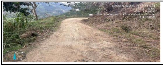
GUADALUPE: TRAMO SARTENEJAL - COROZAL - SINAI K3+600 / K3+800 / K4+950
