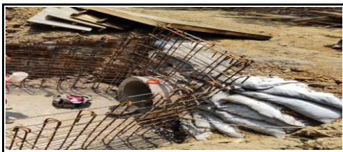
BARAYA: TRAMO BARAYA - LA TROJA - TROJA BAJA K0+500 / K3+300 / K16+100
