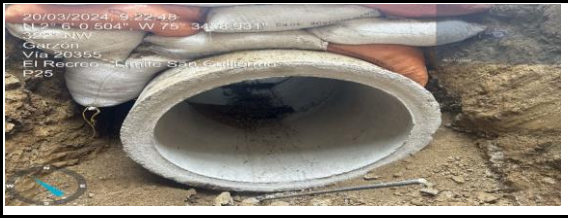
GARZON: TRAMO EL RECREO - LIMITE SAN GUILLERMO K1+700 / K1+920
