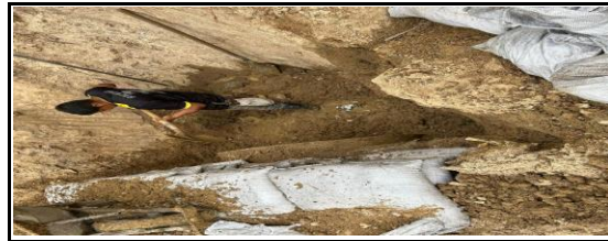
GARZON: TRAMO EL RECREO - LIMITE SAN GUILLERMO K1+700 / K1+920
