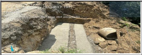
TUBERIA EN EL TRAMO - CAMPOALEGRE
