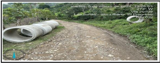
EL PITAL: LAS MINAS - ALTO LIBANO - EL PROGRESO K1+700 / K2+700
