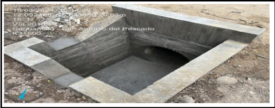
GARZON: TRAMO CAGUANCITO - SAN ANTONIO DEL PESCADO K7+900
