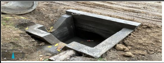
TUBERIA EN EL TRAMO - CAMPOALEGRE
