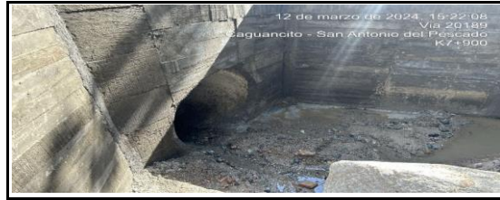
GARZON: TRAMO CAGUANCITO - SAN ANTONIO DEL PESCADO K7+900
