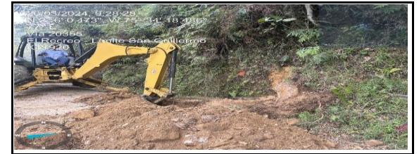
GARZON: TRAMO EL RECREO - LIMITE SAN GUILLERMO K1+700 / K1+920
