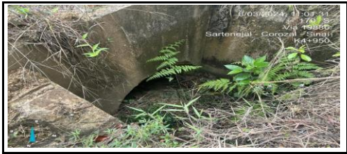
GUADALUPE: TRAMO SARTENEJAL - COROZAL - SINAI K3+600 / K3+800 / K4+950
