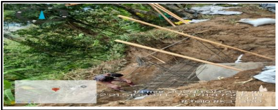
TELLO: TRAMO CRUCE SAN ANDRES - CERRO CASTAÑAL
