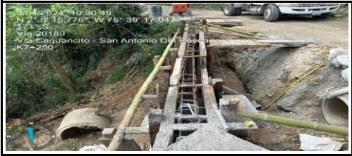
GARZON: TRAMO CAGUANCITO - SAN ANTONIO DEL PESCADO
