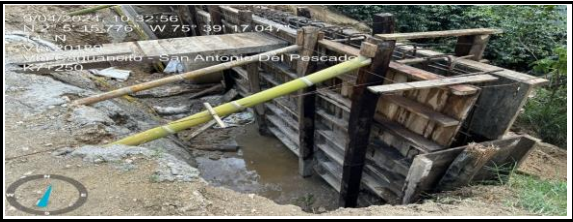
TUBERIA EN EL TRAMO - CAMPOALEGRE
