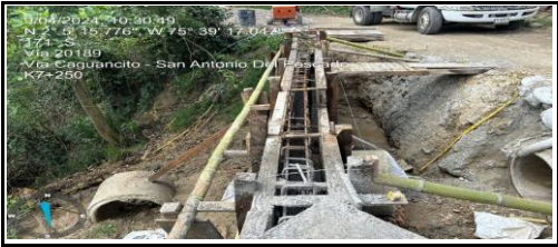
GARZON: TRAMO CAGUANCITO - SAN ANTONIO DEL PESCADO
