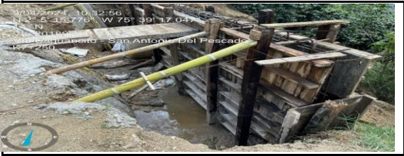
TUBERIA EN EL TRAMO - CAMPOALEGRE
