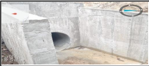
TELLO: TRAMO CRUCE SAN ANDRES - CERRO CASTAÑAL
