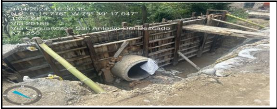
GARZON: TRAMO CAGUANCITO - SAN ANTONIO DEL PESCADO
