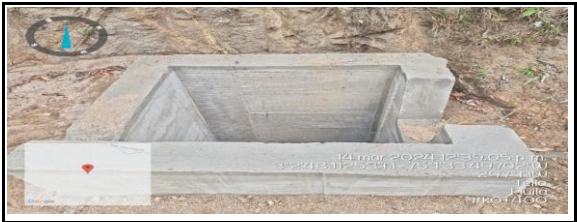
TELLO: TRAMO CRUCE SAN ANDRES - CERRO CASTAÑAL
