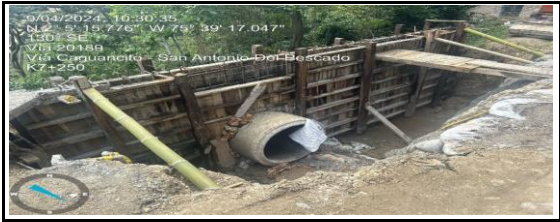
GARZON: TRAMO CAGUANCITO - SAN ANTONIO DEL PESCADO
