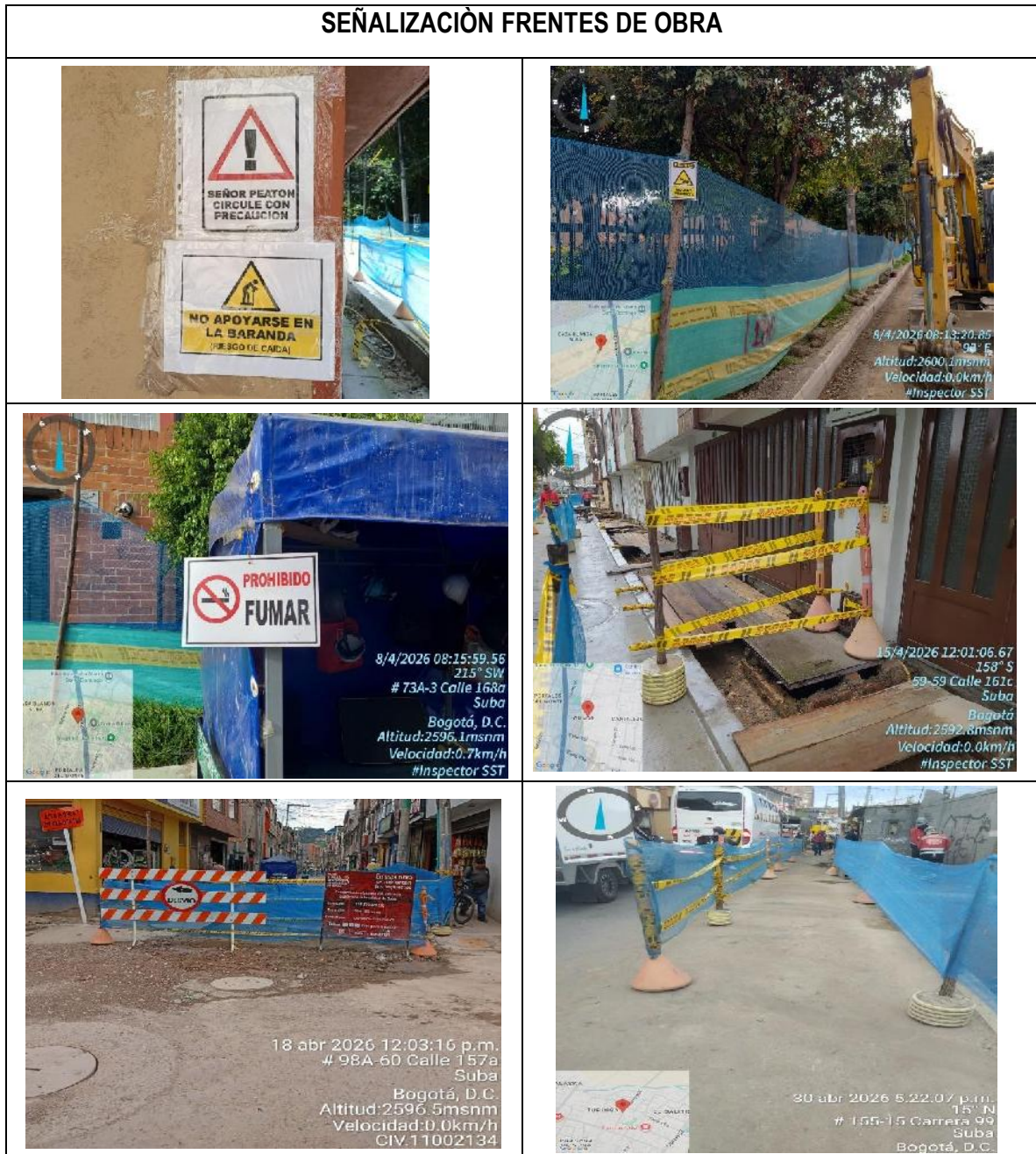
Ilustración No. 28, 29, 30, 31, 32, 33. Señalización en los frentes de obra.
