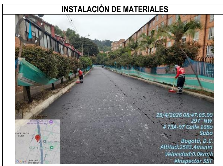
Ilustración No.3. Instalación de Materiales.
