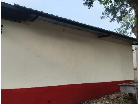
Foto No. 49 condiciones finales.
