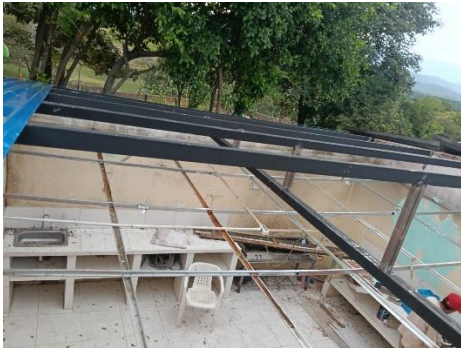
Foto No. 21 ejecución de actividades.
