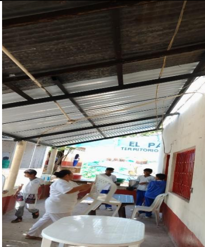
Foto No. 31 ejecución de actividades.
