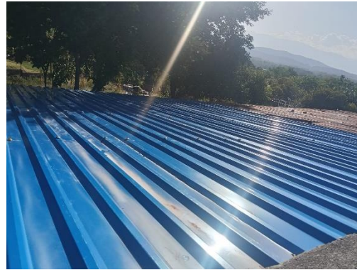
Foto No. 26 ejecución de actividades.
