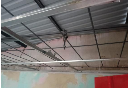
Foto No. 37 ejecución de actividades.
