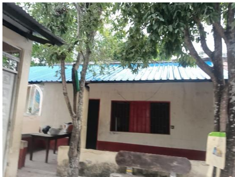
Foto No. 27 ejecución de actividades.
