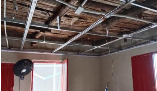
Foto No. 13 ejecución de actividades.
