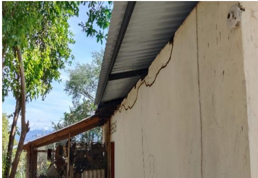
Foto No. 33 ejecución de actividades.
