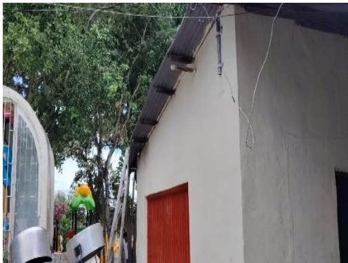
Foto No. 9 ejecución de actividades.
