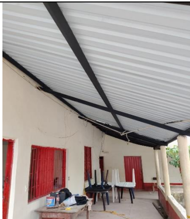
Foto No. 39 condiciones finales.
