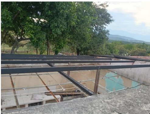
Foto No. 23 ejecución de actividades.
