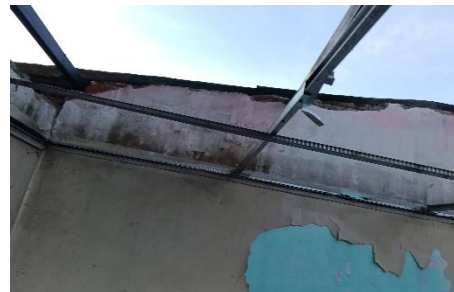
Foto No. 18 ejecución de actividades.
