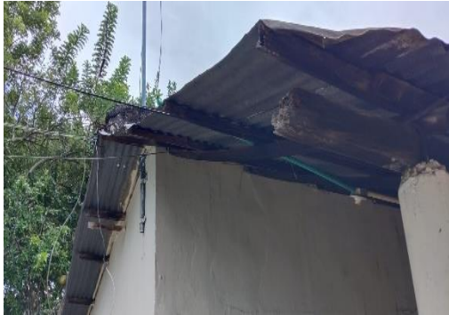
Foto No. 7 ejecución de actividades.
