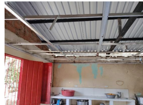
Foto No. 30 ejecución de actividades.
