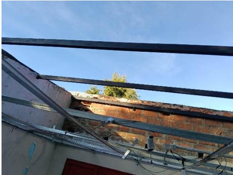
Foto No. 19 ejecución de actividades.
