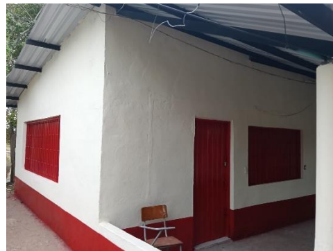
Foto No. 42 condiciones finales.
