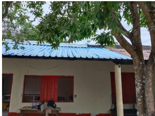
Foto No. 40 condiciones finales.
