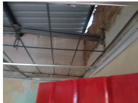
Foto No. 36 ejecución de actividades.
