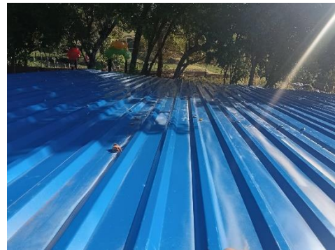
Foto No. 24 ejecución de actividades.
