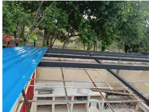
Foto No. 22 ejecución de actividades.
