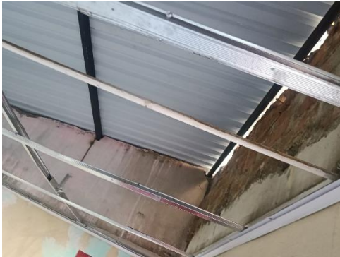
Foto No. 25 ejecución de actividades.
