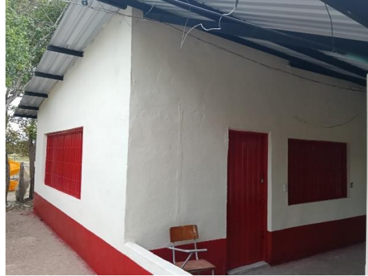
Foto No. 44 condiciones finales.
