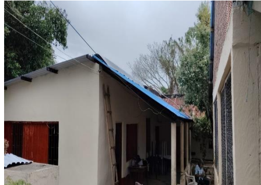
Foto No. 38 condiciones finales.
