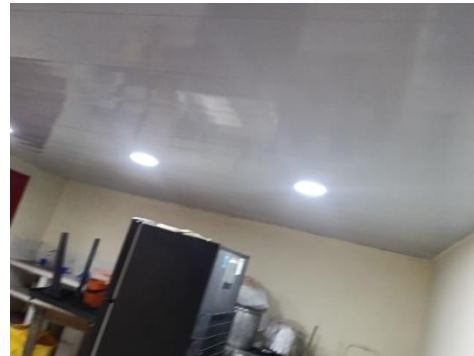
Foto No. 48 condiciones finales.
