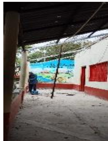
Foto No. 12 ejecución de actividades.
