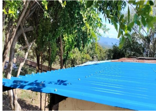
Foto No. 34 condiciones finales.
