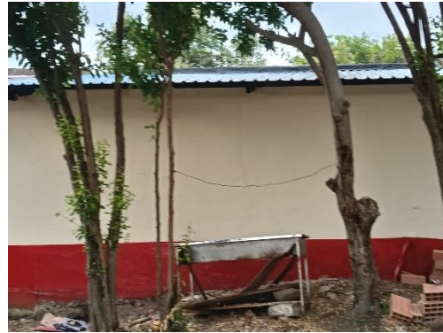
Foto No. 50 condiciones finales.
