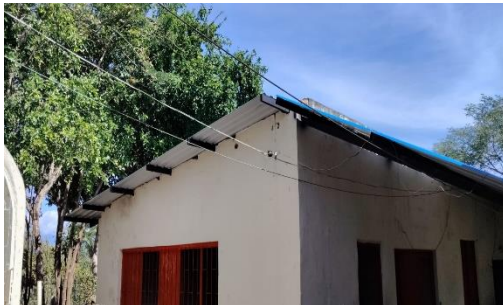
Foto No. 35 ejecución de actividades.
