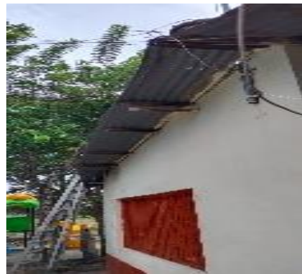
Foto No. 10 ejecución de actividades.
