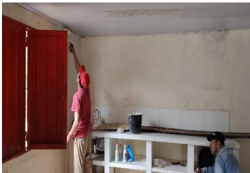
Foto No. 41 ejecución de actividades.
