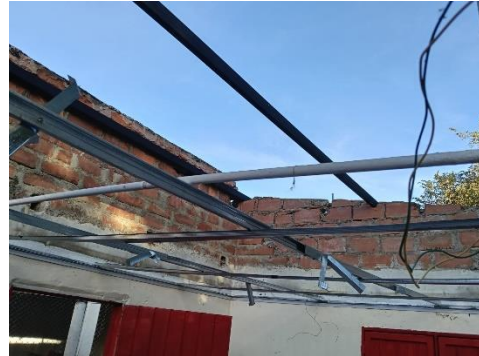
Foto No. 20 ejecución de actividades.
