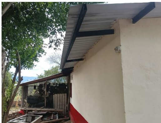
Foto No. 53 condiciones finales.
