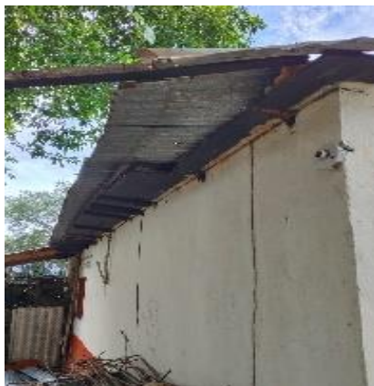
Foto No. 11 ejecución de actividades.
