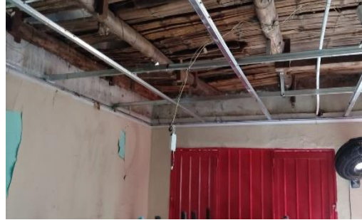
Foto No. 14 ejecución de actividades.
