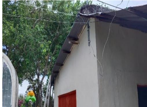
Foto No. 8 ejecución de actividades.
