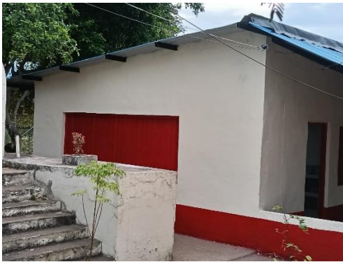
Foto No. 51 condiciones finales.
