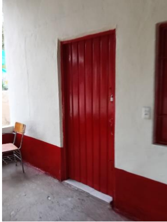
Foto No. 43 condiciones finales.
