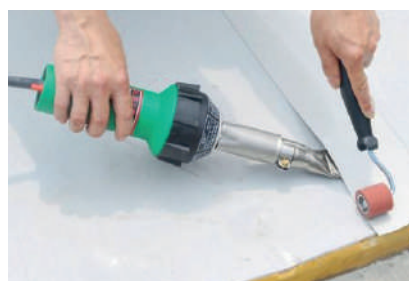
3. Termo fundido de la membrana
