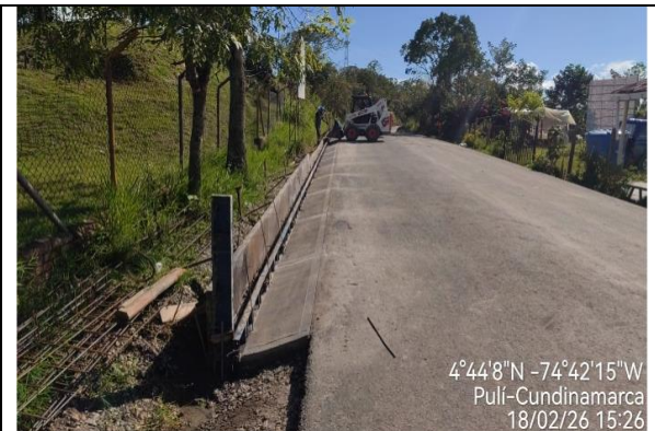
Foto 36. Fundición de bordillo derecho K4+800
