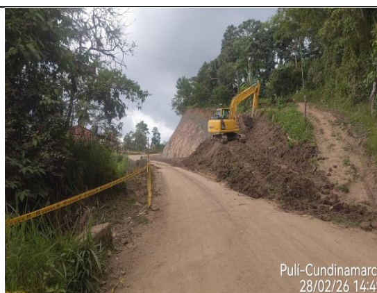
Foto 50. Corte de talud derecho K5+650
