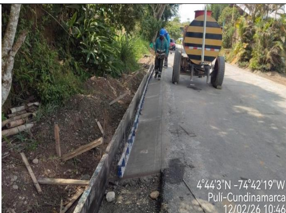
Fuente: Interventoría Consorcio ID Cundinamarca 043 Foto 28. Formaleta para bordillo K4+640
