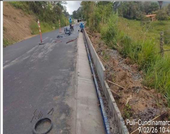
Foto 21. Formaleta para bordillo derecho K4+500
