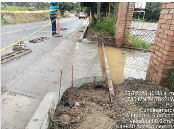
Fuente: Interventoría Consorcio ID Cundinamarca 043 Foto 45. Accesos fundidos, colegio Paramón
