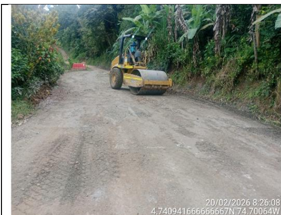
Foto 39. Compactación de material de subbase K5+520
