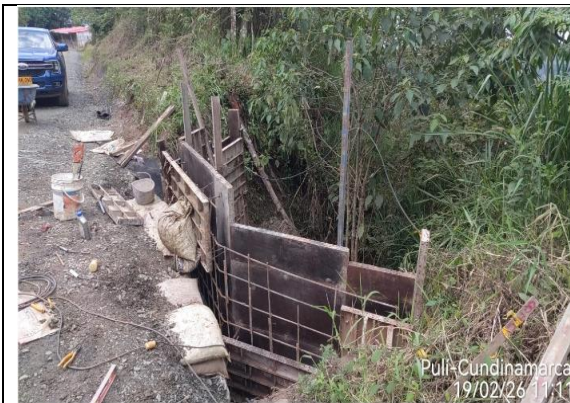
Foto 37. Encofrado descole K5+860
