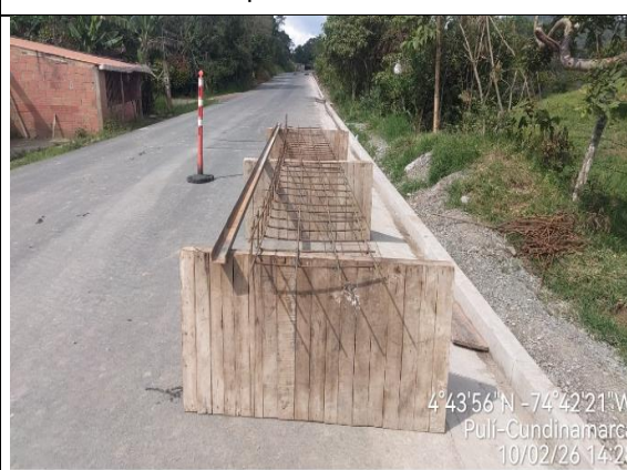
Foto 21. Formaleta para bordillo derecho K4+500
