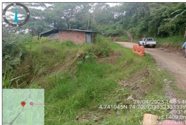
Fuente: Interventoría Consorcio ID Cundinamarca 043 Foto 12. K5+600 estado inicial
