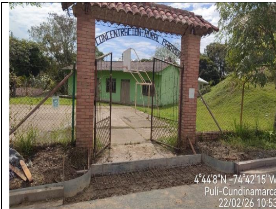
Fuente: Interventoría Consorcio ID Cundinamarca 043 Foto 43. Acero para Acceso derecho K4+830
