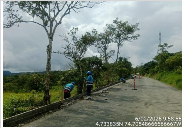
Foto 20. Concreto para cunetas costado derecho k4+560
