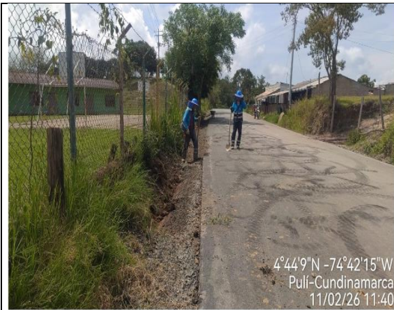
Fuente: Interventoría Consorcio ID Cundinamarca 043 Foto 25. Replanteo de cuneta K4+800
