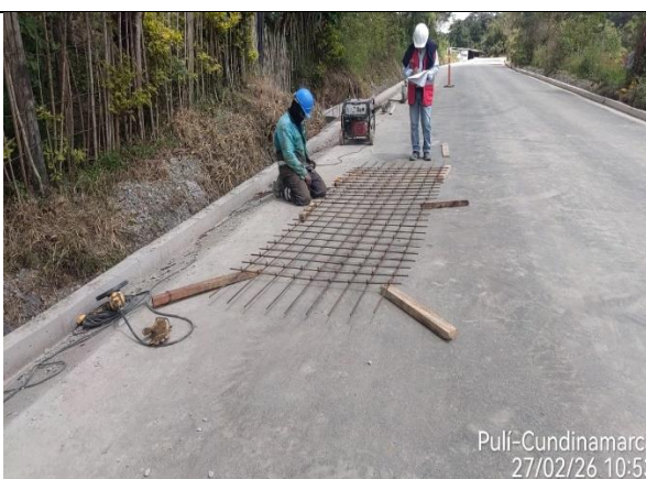
Fuente: Interventoría Consorcio ID Cundinamarca 043 Foto 30. Amarre de acero para acceso K4+480 C.I.
