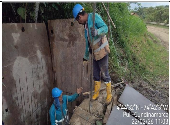
Fuente: Interventoría Consorcio ID Cundinamarca 043 Foto 44. Figurado de Hierro para encofe K5+720
