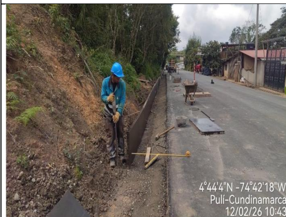
Fuente: Interventoría Consorcio ID Cundinamarca 043 Foto 27. formaleta para cunetas K4+680
