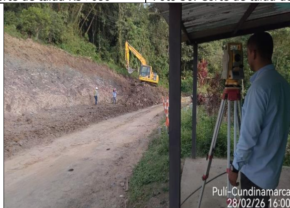
Foto 51. Replanteo para corte de talud K5+635
