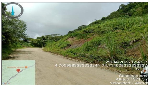
Fuente: Interventoría Consorcio ID Cundinamarca 043 Foto 1. K0+920 – K1+040 estado inicial punto crítico No 1
