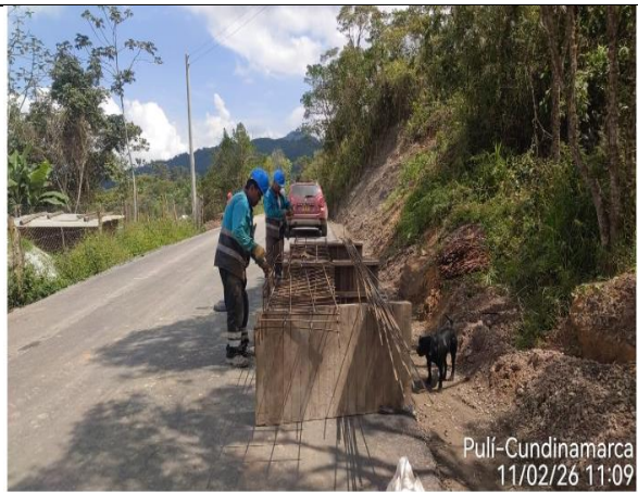
Fuente: Interventoría Consorcio ID Cundinamarca 043 Foto 26. Figurado de Hierro para cunetas
