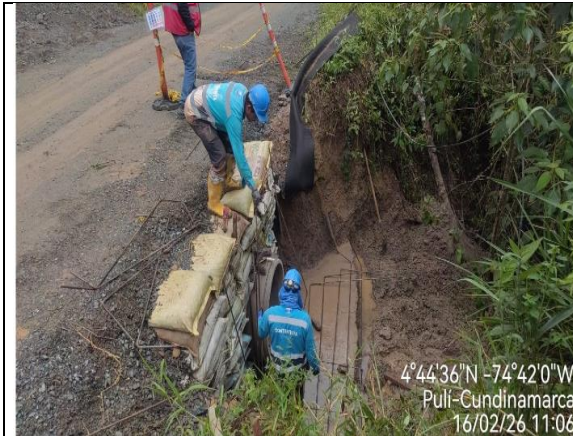
Foto 31. Figurado de acero para descole K5+860
