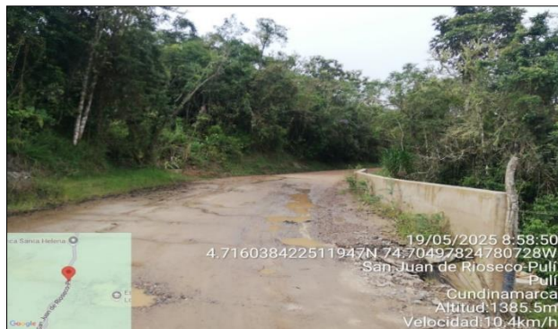
Fuente: Interventoría Consorcio ID Cundinamarca 043 Foto 6. K2+440- K2+600 estado inicial punto crítico No 5
