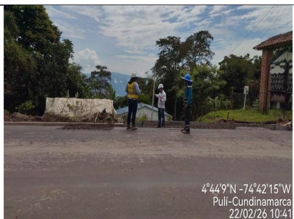
Foto 42. Nivelación de acceso derecho K4+880
