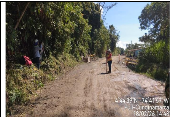
Foto 35. Replanteo de eje K5+980
