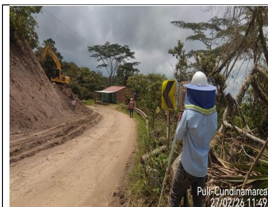
Foto 49. Replanteo para corte de talud K5+680
