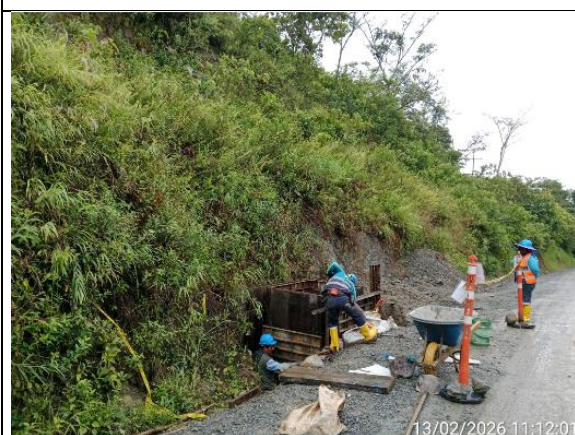
Fuente: Interventoría Consorcio ID Cundinamarca 043 Foto 29. Encofrado encole K5+860
