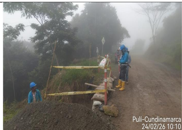
Fuente: Interventoría Consorcio ID Cundinamarca 043 Foto 46. Actividades en descole K5+720
