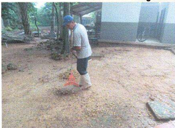
Realizando mantenimiento instalaciones del centro
