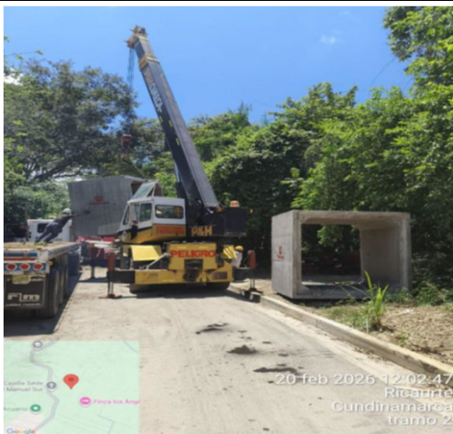
Fotografía 7: Instalación Box Culvert tramo 2
