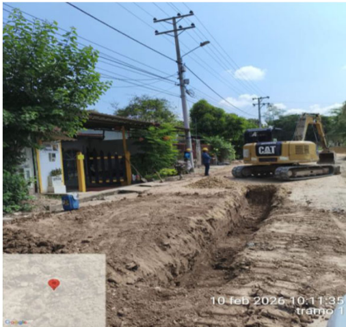
Fotografía 1: Actividades de excavación y rellenos para red de acueducto
