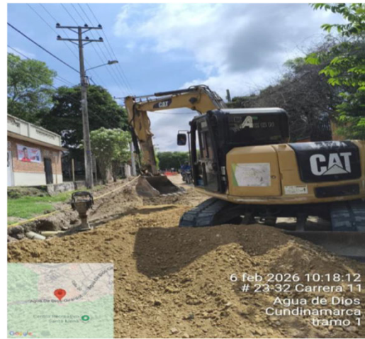
Fotografía 2: Actividades de excavación y rellenos para red de acueducto
