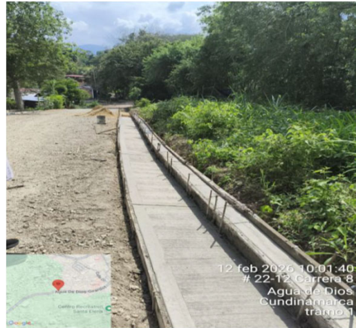
Fotografía 4: Actividades de vaciado de concreto de 4000PSI para cunetas
