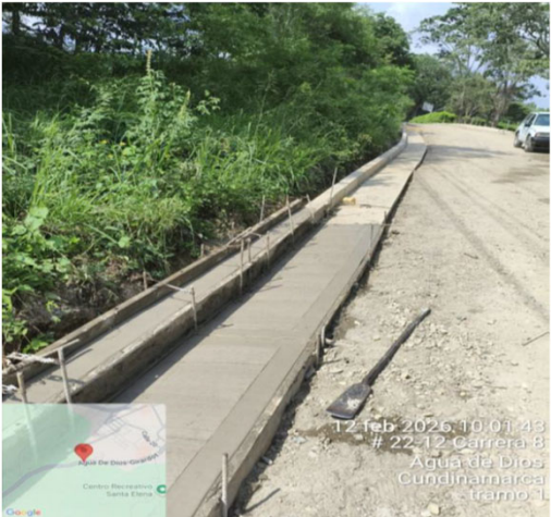
Fotografía 3: Actividades de vaciado de concreto de 4000PSI para cunetas
