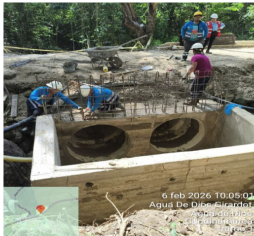
Fotografía 6: Encole alcantarilla doble
