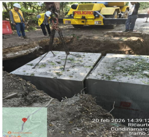
Fotografía 8: Instalación Box Culvert tramo 2
