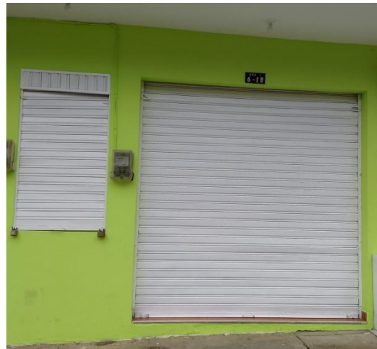
Figura 6. Parte externa – Punto de Acopio Balboa, Cauca
