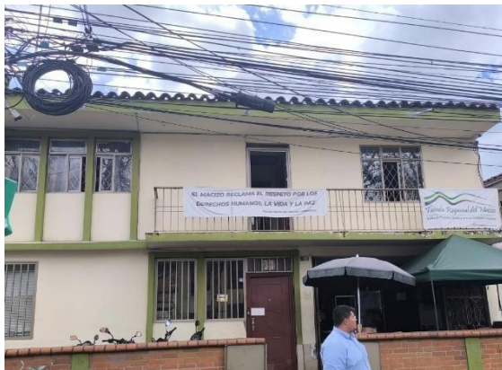
Figura 11. Parte externa – Sede administrativa Popayán, Cauca
