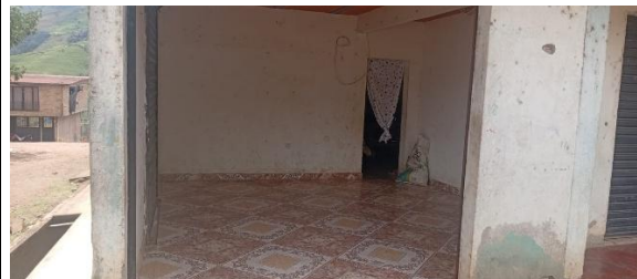
Figura 10. Parte interna – Punto de Acopio Mercaderes, Cauca
