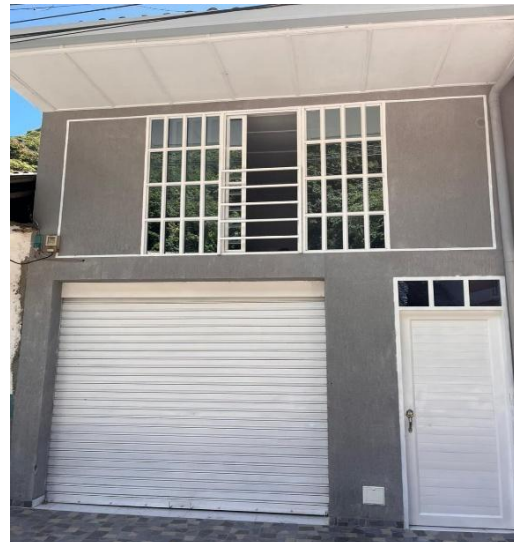
Figura 8. Parte externa – Punto de Acopio Balboa, Cauca
