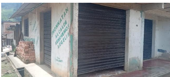
Figura 9. Parte interna – Punto de Acopio Mercaderes, Cauca
