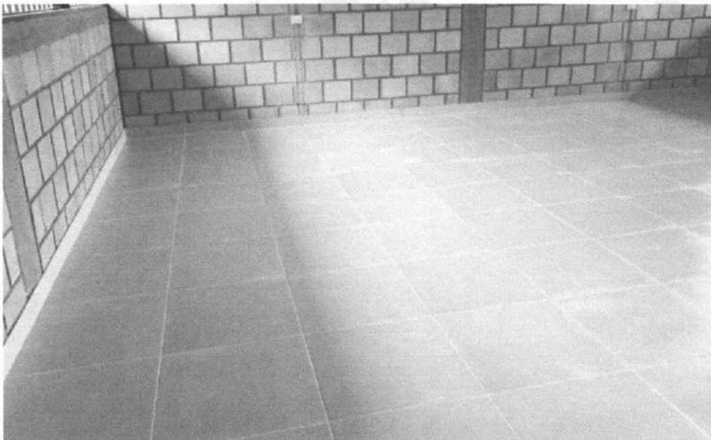
CERÁMICA INSTALADA AULA ESCOLAR
